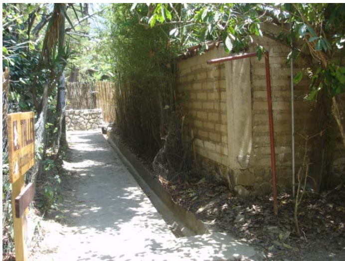
Fotografía 39. Deterioro de caminamiento, cercos de malla galvanizada, falta de rejilla en cuneta, deterioro de adoquín en caminamiento. Presencia de tubos galvanizados sin rótulos, falta de iluminación.
