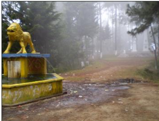
Debido a la falta de servicio de drenajes y alcantarillado en el sitio se tiene problema de empozamiento.
