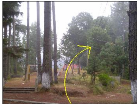
Red de energia electrica que sirve para actividades que se realizan en el sitio
