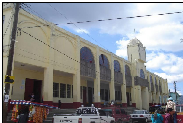
EDIFICIO SALÓN USOS MÚLTIPLES.
