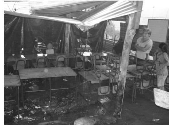
2.4.2.2 Foto No. 4 y 5 En estas fotografías observamos las aulas de la Escuela Comunitaria del Barrio San Miguel, como el agua pluvial se filtra por las laminas de zinc en que se encuentran en mal estado y deterioradas así mismo ingresa el agua por los lados a causa de no haber paredes dando como resultado el deterioro del mobiliario escolar de los educandos.
