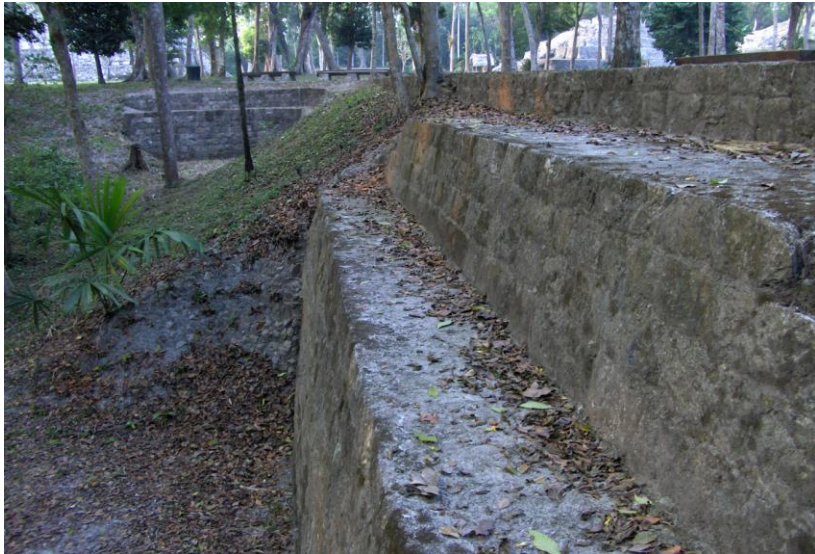
Foto 18: Calzada Blom, parapeto y muro de contención Oeste, Fotografía: Pedro Gordillo 2008.
