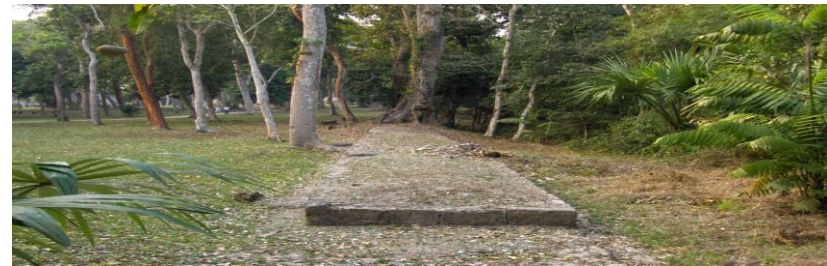
Foto 6 : Calzada Blom. Parapeto parte oeste de la calzada. Fotografía : Pedro Gordillo.
