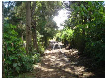
Vista Parcial Acceso Primario – Visita de Campo
