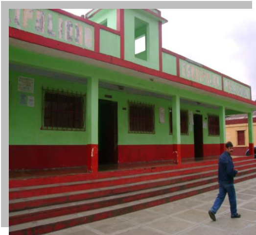
Fotografía No.1 Ingreso principal a edificio municipal, cuenta con don ingresos para atención al público Imagen: Leticia Bautista
