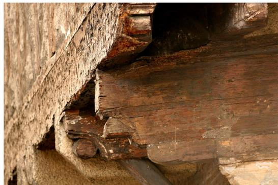
FIGURA No. 14 Intemperismo de la madera. Podemos apreciar en esta figura los efectos del intemperismo en varas piezas de madera.
