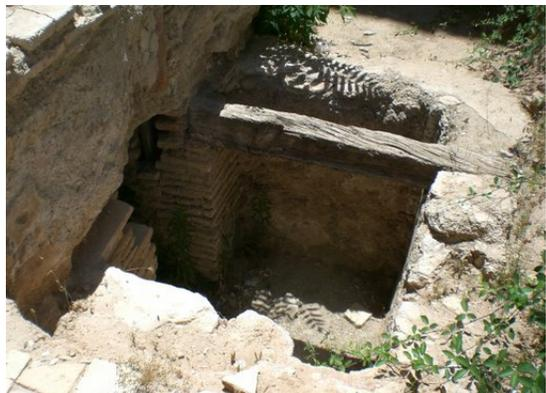
FIGURA No. 13 Conservación de la madera. Se puede apreciar que cuando una pieza de madera está al resguardo del ambiente, se conserva por varios siglos.
