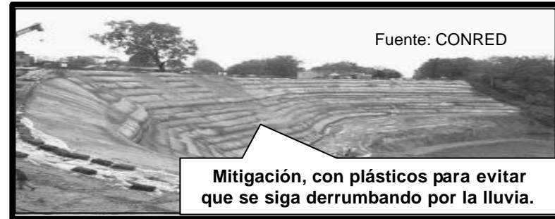
Fotografía No. 6-T, Mitigación con terraplenes.
