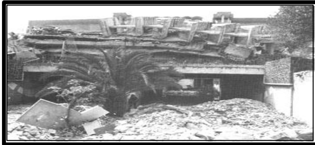
Fotografía No. 17-T, Terremoto 1976, Área Urbana, en Guatemala. FUENTE: HISIVUMEH., 1978.
