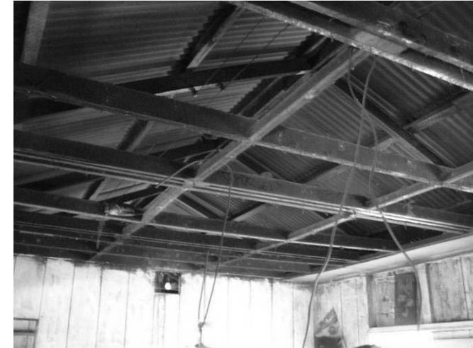
Foto 79. Entramado de cubierta final a base de tijeras de madera, costanera y lámina metálica en Sección 24.
