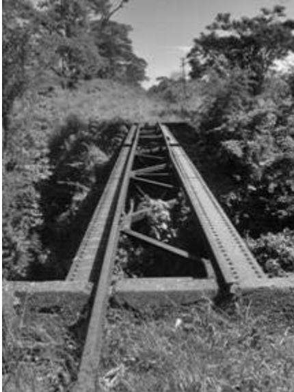
Foto 13. Abandono de infraestructura ferroviaria. puente en tramo entre Cuyotenango y Mazatenango.
