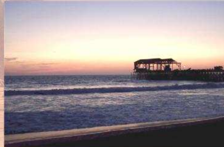
MUELLE DEL PUERTO DE CHAMPERICO, RETALHULEU.
