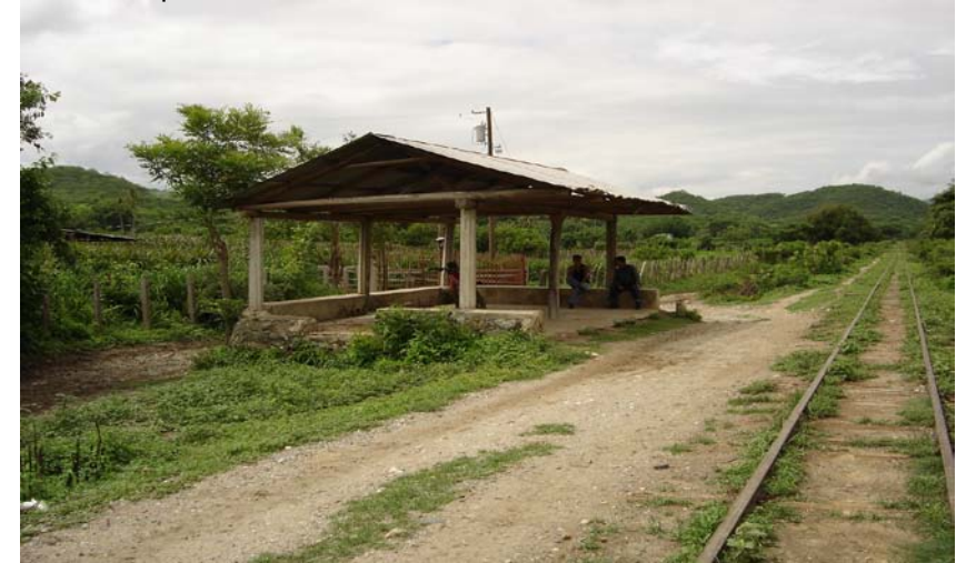
Foto 38 Milla 99 Entorno de la estación.
