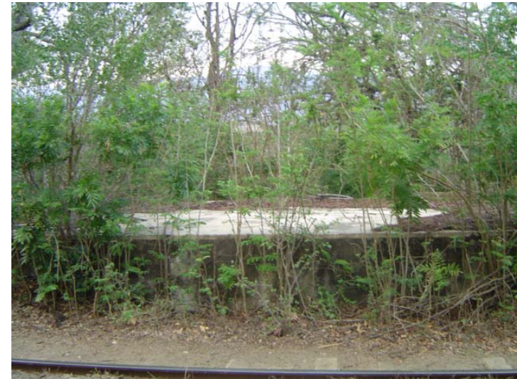
Foto 26 Estación Choyoyó. Vestigios de la plataforma de carga
