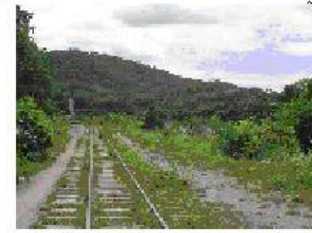
Toma 'G'. Vista de las vías de ferrocarril hacia Gualan, desde la estación de San Pablo.
