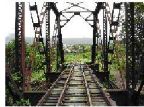
Foto 102. Puente ferroviario en buenas condiciones y funcionando.
