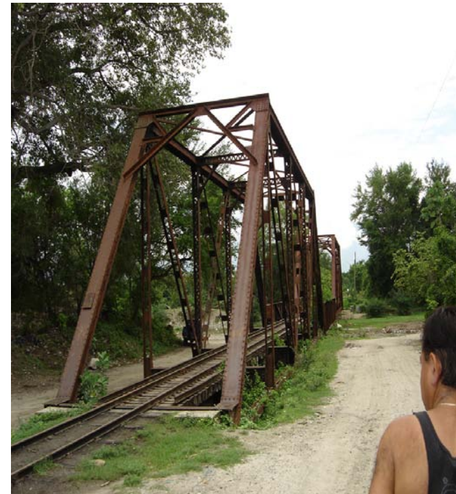
Foto 40 Milla 102.8 en la foto Puente de Zacapa, Barrio el Hoyo, rumbo a Puerto Barrios.
