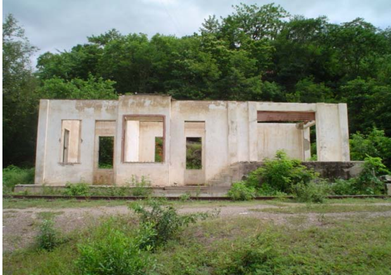
Foto 1 Estado actual de la fachada principal de la Estación San Pablo. Milla 94.3
