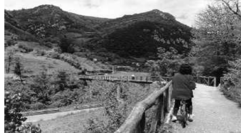
Foto 8 La reconstrucción de los viejos puentes ferroviarios permite mantener el suave perfil del itinerario, aunque atraviese áreas de abrupta orografía (Vía Verde de la Senda del Oso)
