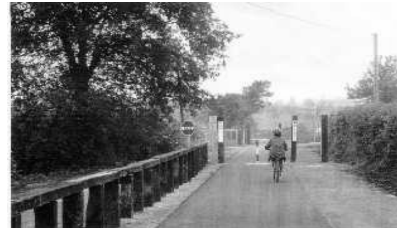
Foto 8A Intersección típica utilizando antiguas traviesas ferroviarias como base para la señalización y los cerramientos laterales (Vía Verde de La Camocha.)
