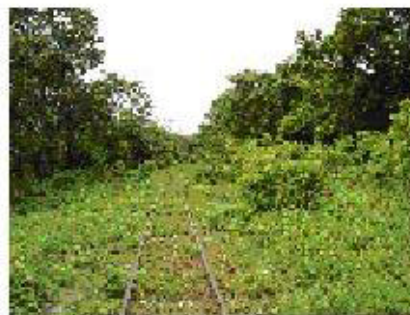
Tufo 18. Vía de ferrocarril donde se ve el cambio a vegetación de agua.
