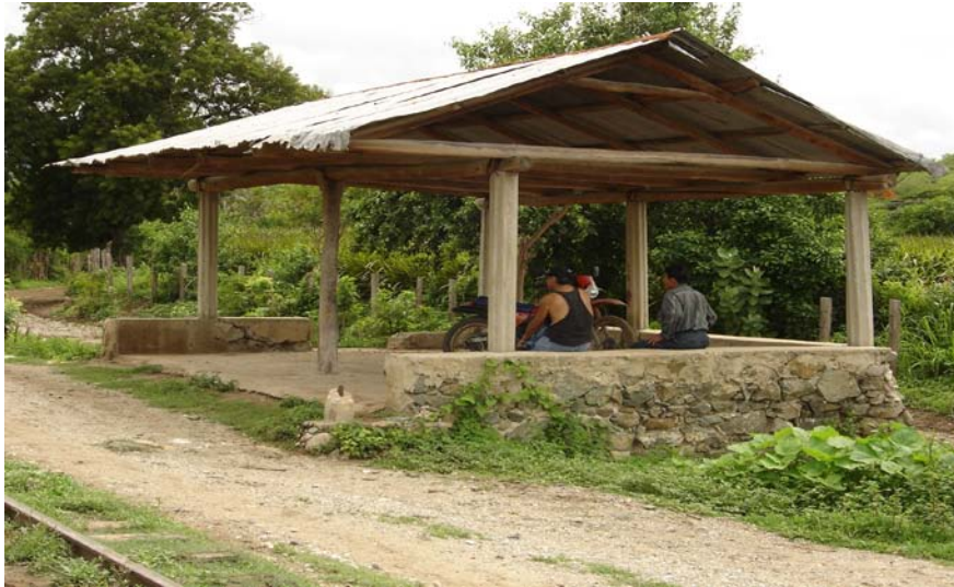
Foto 37 Milla 99 donde funciona la estación Manzanotes. En la fotografía la estación que construyeron y utilizan los vecinos del lugar.
