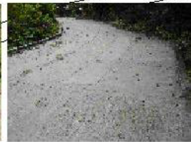
Toma '17'. Curbado de concreto que protege a la vía de la estación.
