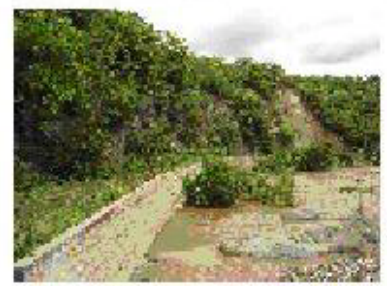
Toma '2'. Muro de concreto que protege a la vía de tren de deslizamientos.
