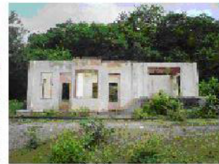
Toma 'D'. Fachada principal de la Estación San Pablo.
