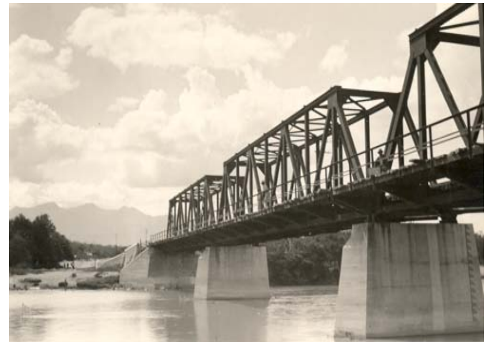
Foto 14 Puente Negro, sobre el Río Grande de Zacapa, Zacapa. Fuente: Archivo -FEGUA-
