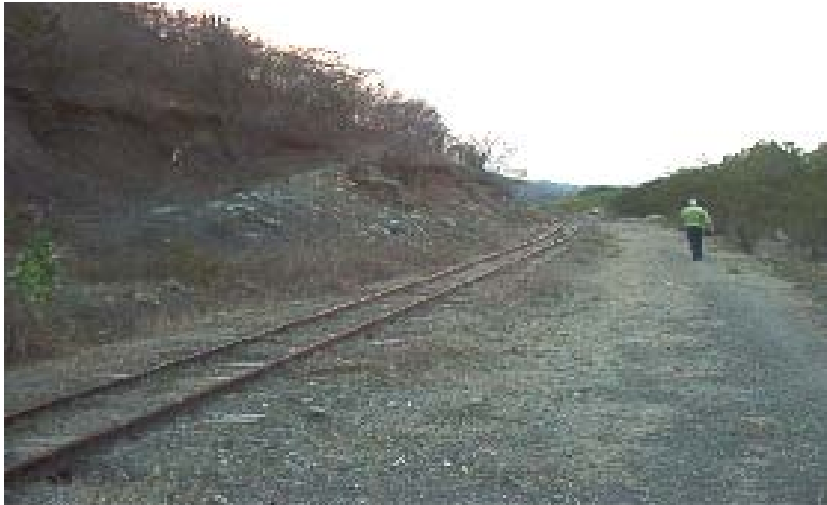
Foto 27 Milla 93.7 donde funcionó la estación Capulín la cual solo servia como desvío de trenes.
