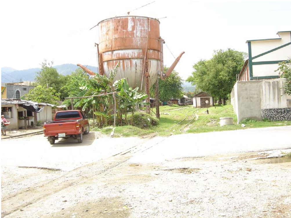
Foto 18 Milla 82.1 donde funciona la estación Central de Gualán, en la foto. Barrio la estación, salida de la estación con rumbo a Zacapa.
