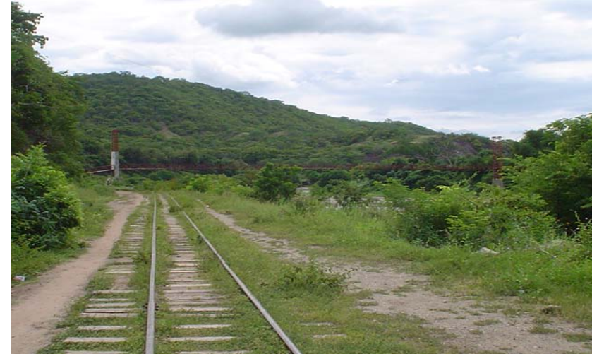
Foto 4 Pueden verse las vías y el entorno totalmente abandonados. Al fondo puente colgante milla 94.3
