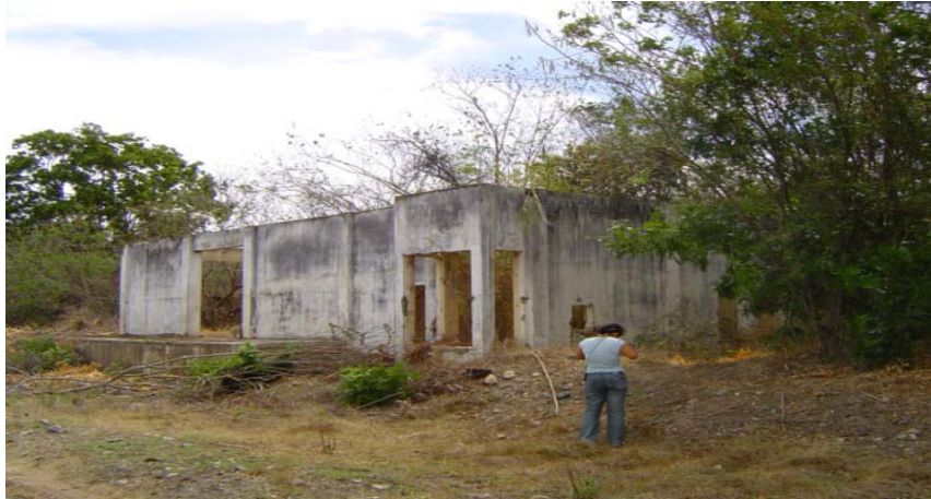
Foto 35 Milla 98 donde funcionó la estación Pepesca. En la foto, lo que queda de mampostería y concreto, de la estación.
