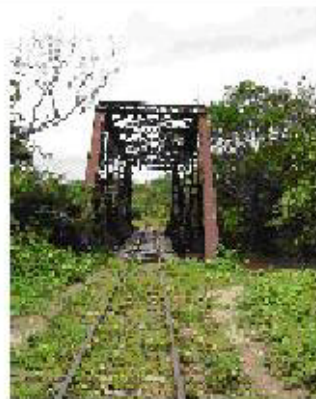
Tufo 12. Puente nuevo en que queda su estructura. En Motagua donde termina el desvío. El desvío ya no es suelto, fue desmontado y removido para dar paso al TCGJ.
