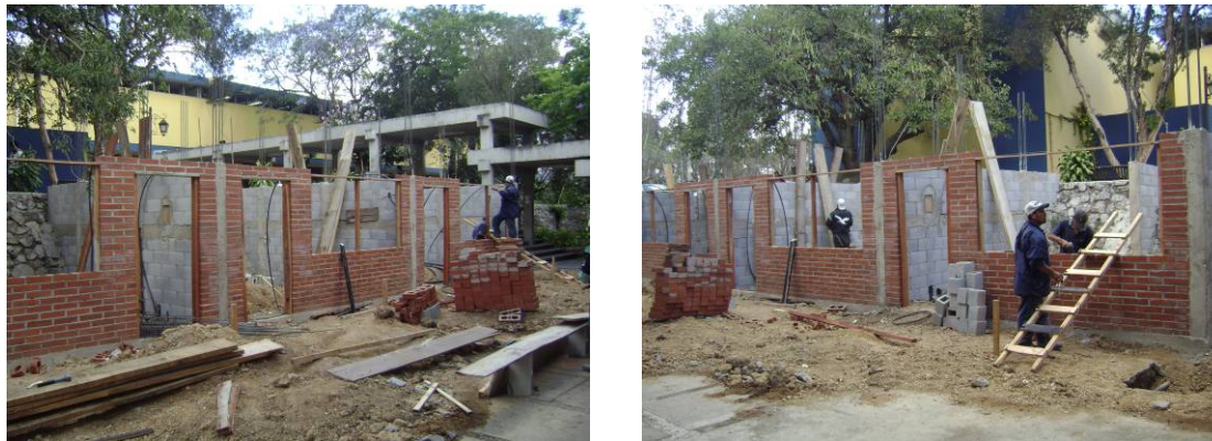
Módulos comerciales en construcción marzo 2008 entre edificio T-1 y T-2.
