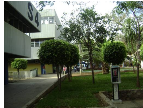
Edificio S-4 módulo típico de concreto reforzado.
