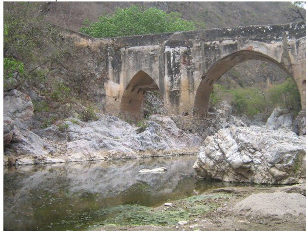
Fotografía No.22 Puente de la Barranquilla Fuente: elaboración propia, Octubre 2007.
