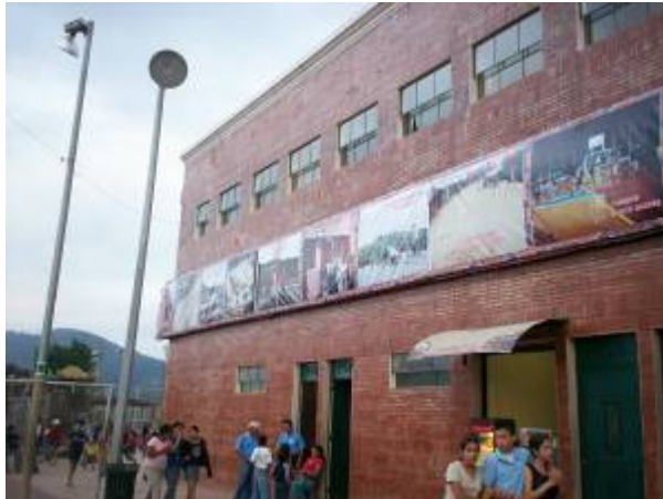
POLIDEPORTIVO, CHINAUTLA, GUATEMALA. FOTOGRAFÍA 1.4. Aquí se puede observar la entrada a los baños con los que cuenta el gimnasio. FUENTE: SAYRA CORDÓN 2008.
