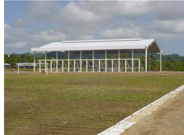
POLIDEPORTIVO, LIVINGSTON, IZABAL. FOTOGRAFÍA 1.1 Aquí se observa la fachada del polideportivo. FUENTE: SAYRA CORDÓN 2008.
