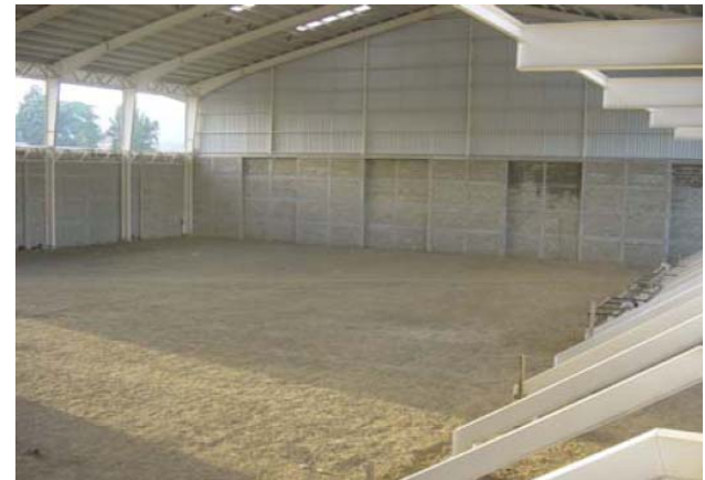
POLIDEPORTIVO, LIVINGSTON, IZABAL. FOTOGRAFÍA 1.2. Los muros no se construyeron hasta el principio de la cubierta, esto se debe a que tiene una ventilación cruzada, por el clima cálido húmedo del lugar. FUENTE: SAYRA CORDÓN 2008.
