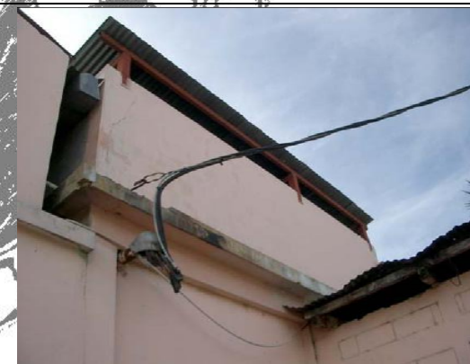
FOTOGRAFÍA 31 AÑADIDURA DE DEPÓSITO DE AGUA AÉREO
