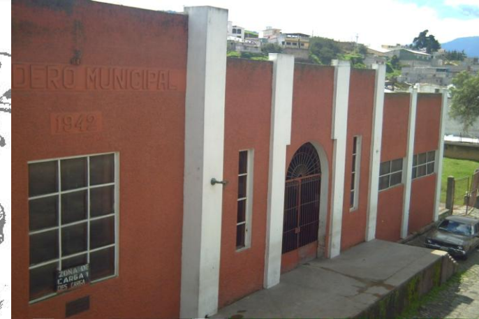
ACTUAL ELEVACIÓN FRONTAL DEL RASTRO FOTOGRAFÍA 19
