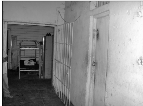
FOTO No.28. Ingreso lateral hacia comedores
