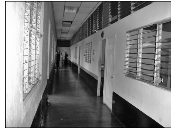
FOTO No.61. Distribución de oficinas corredor interno
