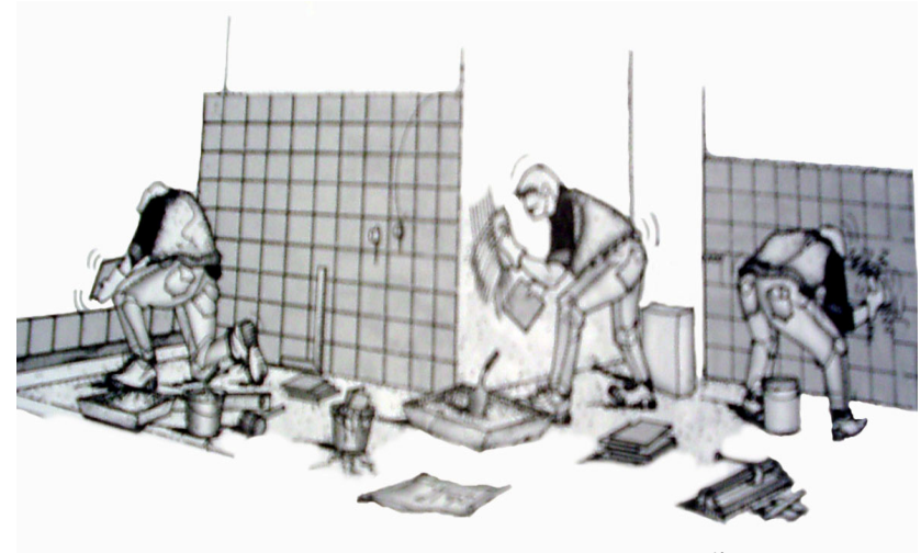
COLOCACION DE PISO Y AZULEJO EN BAÑOS
