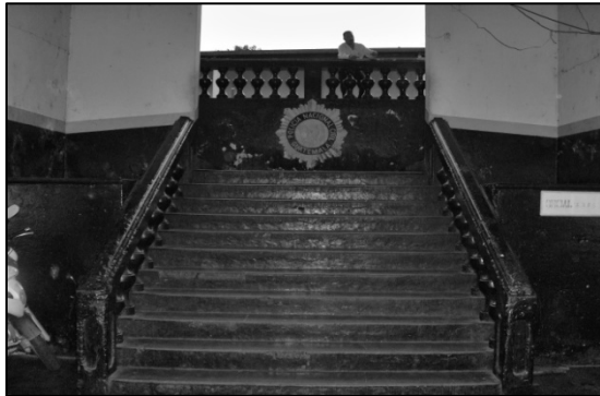
FOTO No.27. Escalera de Ingreso Principal
