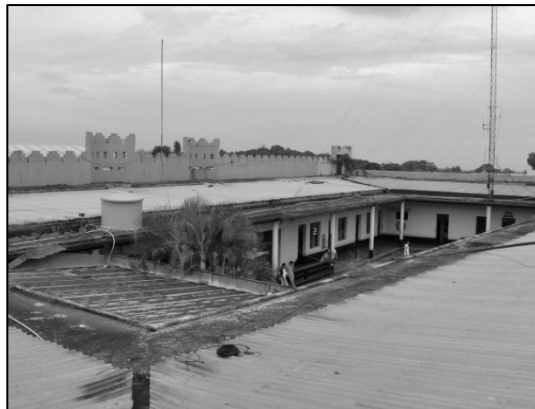
FOTO No.78. Instalaciones de agua potable
