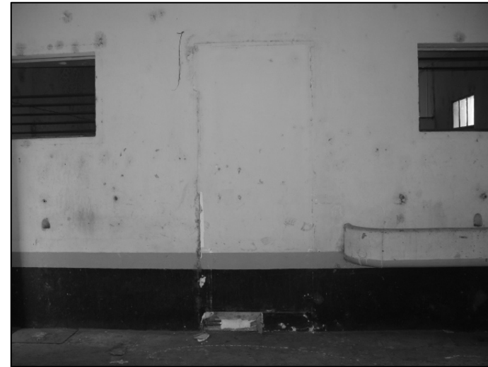
Estado general de muros internos
