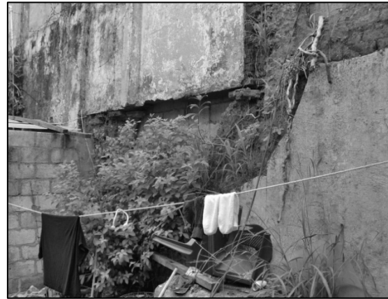
FOTO No.55. Muro colindante contiguo a bomba
