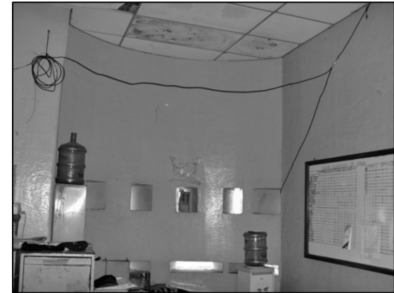
FOTO No.72. Instalaciones oficina DINC 1er nivel
