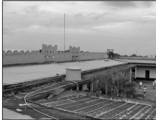
FOTO No.76. Vista hacia patio central y fachada
