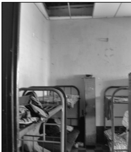
FOTO No.68. Cielo falso dormitorio oficiales
