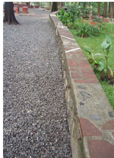
FOTO No.30: Muro de piedra y laja.
