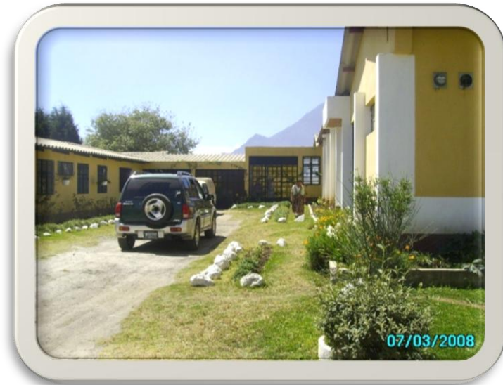
FOTOGRAFÍA No. 6 ENTRADA Y FACHADA PRINCIPAL DEL HOGAR DE ANCIANAS LUISA DE MARILLAC.
