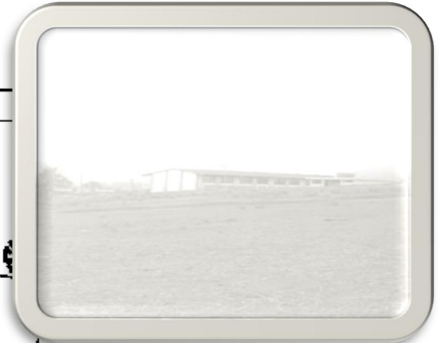
FOTOGRAFÍA No. 17 VISTA ESTE
