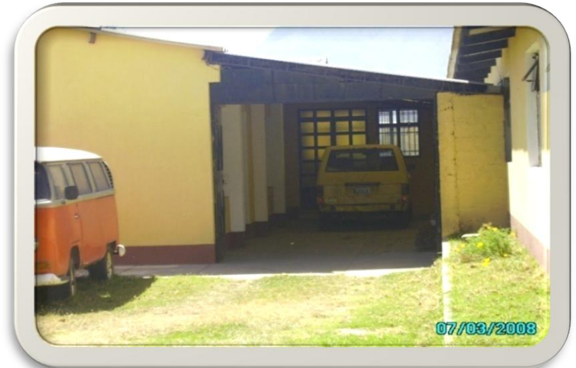
FOTOGRAFÍA No. 14 INGRESO DE SERVICIO
