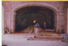
Consolidación y limpieza de muros, eliminación de piso no original.
