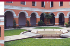
Construcción del espejo de agua.
