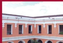
Integración de terrazas españolas y Cubiertas de dos aguas con armaduras de Madera, lamina de fibrocemento y teja.
