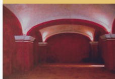
Integración de piso, color e instalación eléctrica.
