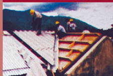
Construcción de cornisas y adornos.
