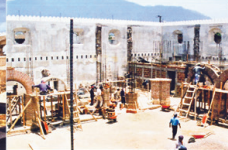
Proceso de consolidación de los muros con reposición de material faltante en grietas, cuarteaduras, inyecciones con material consolidante, construcción de solera de corona, etc.
