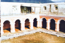
Completación del interior instalaciones eléctricas y sanitarias, pisos, acabados, etc.
