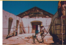
Consolidación de fisuras, grietas, cuarteaduras y repellos.
