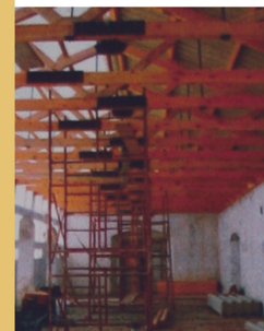
Integración de piso, color, zócalo, puertas, ventanas e instalación eléctrica.
