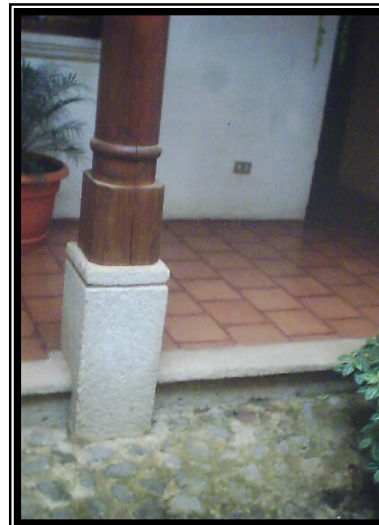
Foto 4.2.3.6.: En la fotografía se muestra el uso de materiales de la región que proporcionan textura y color como lo es la baldosa y la piedra. Materiales de construcción utilizados en el municipio de Ciudad Vieja.
