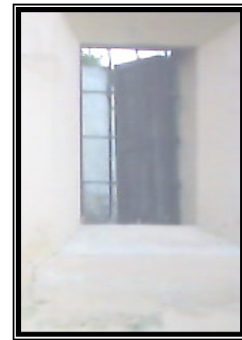
Foto No. 4.2.3.4.: Se observa Ventana con derrame exterior con enrejado de metal.
