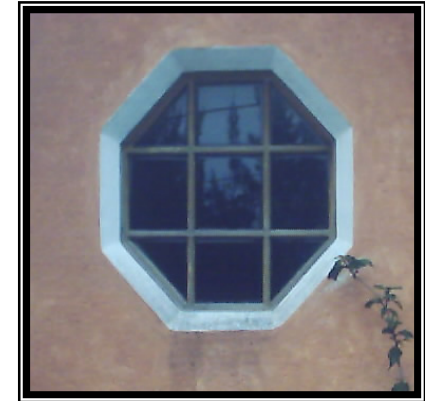
Foto No. 4.2.3.1. Ventana hexagonal con derrame de una vivienda en Ciudad Vieja en la actualidad con marco de madera y vidrio.
