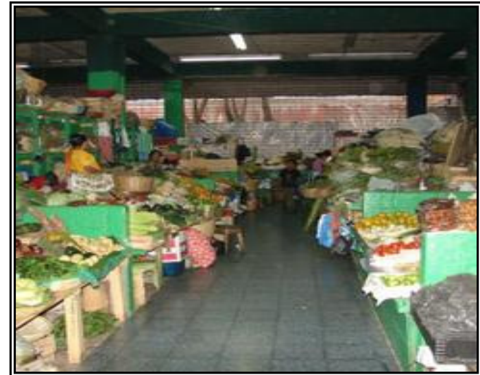
Fotografía 2.8.1.2. Área piso-plaza del Mercado Central del municipio de Guatemala ubicado en la zona 1. En la fotografía se aprecia las ventas de hortalizas, verduras y frutas. Además se puede observar que la estructura es de columnas y vigas de concreto armado.
