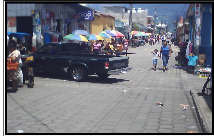
Fotografía 3.7.3. Fachada lateral del Mercado Municipal, muestra el deterioro de éste, así como de ventas informales sobre la calle.
