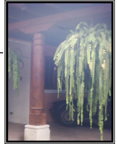
Foto 4.2.3.5.: Pilar de madera con base de concreto martelinado elemento arquitectónico utilizado en la región.
