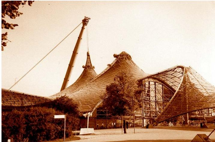
Los materiales traslúcidos, las estructuras metálicas y los cables tensados recalcan la idea de la Alta Tecnología
