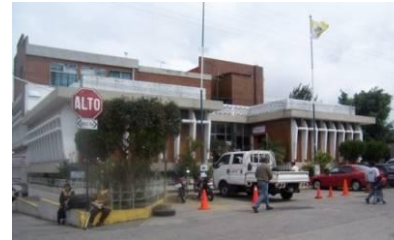
FOTO NO. 18 ESTADO ACTUAL DEL ACTUAL EDIFICIO MUNICIPAL
