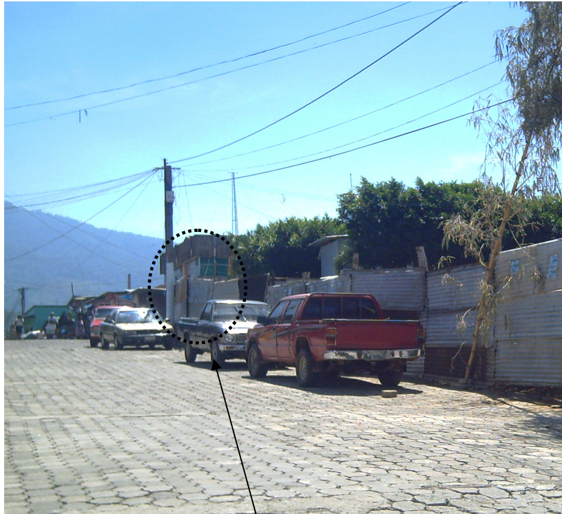
Foto 4: El entorno de la Municipalidad vista desde la 3ra Calle: no existe identidad arquitectónica con lo que los edificios vecinos, que deberían tener significado a nivel arquitectónico
