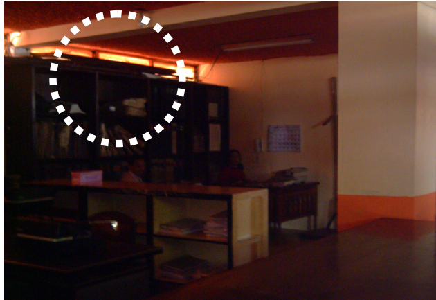
Foto 12: La Tesorería está mal ubicada respecto a función e iluminación, ya que la ubicación de las ventanas están orientadas en donde incide la insolación. Fuente: Imagen Propia, octubre de 2008.
