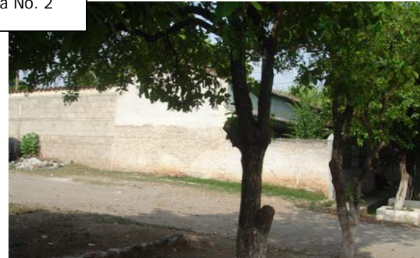
VISTA 2: Frontal Izquierda (observamos el área de banqueta e ingreso al predio)
