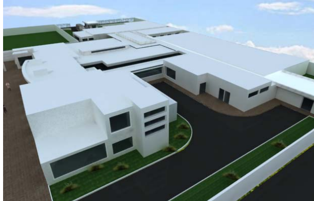
Administración, área de carga y descarga
