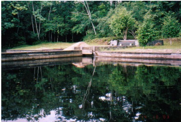
Foto No. 25 Tanques de desarenado Fuente/Propia junio 2006
