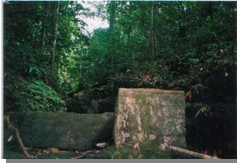
Foto No. 23 Captación de agua proveniente de las zonas altas de la montaña, van hacia un desarenador Fuente/Propia junio 2006
