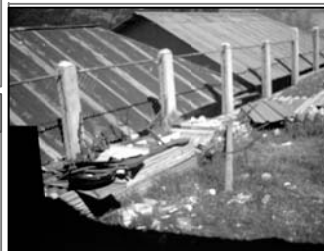
Foto No.2: perímetro del edificio
