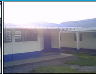
Foto No.4: modulos construidos por intervida
