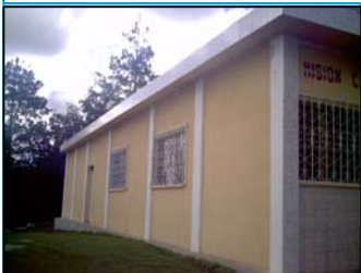
Foto No.1: proteccion en vidrio con balcones
