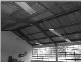
Foto No.1: estructura de techo en buenas condiciones
