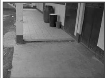
Foto No.5 y 6: piso exterior de torta de concreto y piso de granito en buenas condiciones
