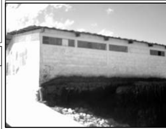
Foto No.2: perímetro del edificio
