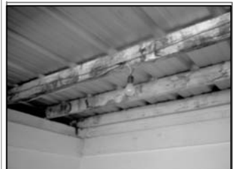
Foto No.5 y 6: instalaciones electricas expuestas
