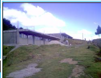
Foto No.3: se puede observar que el edificio se encuentra en un terreno quebrado
