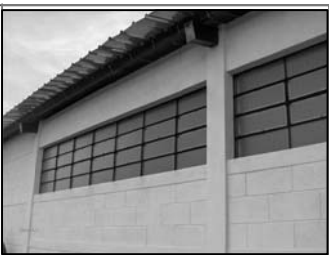
Foto No.2: ventanas en buen estado
