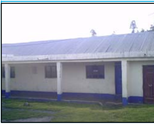
Foto No.2: vista lateral del edificio
