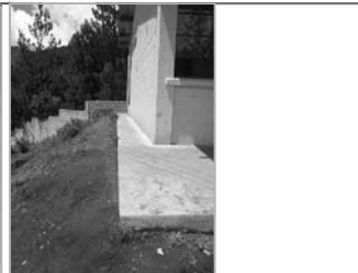
Foto No.3: talud existente de 1.5m de altura
