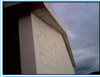
Foto No.5 y 6: paredes de block visto
