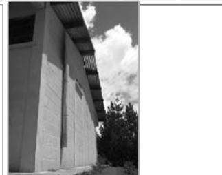
Foto No.7: Se puede observar el buen estado de la cubierta de techo, de lamina
