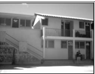
Foto No.3: modulo de dos niveles con marco estructural
