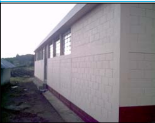
Foto No.2: vista lateral del edificio
