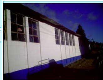
Foto No.2: vista lateral del edificio
