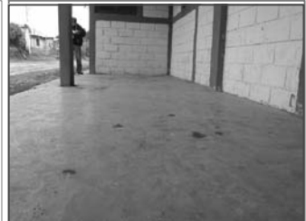
Foto No.7: piso de torta de concreto
