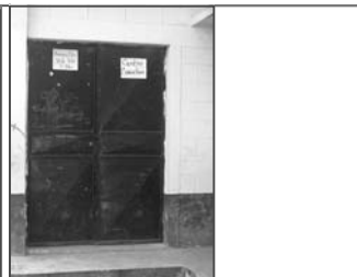
Foto No.3: puertas de metal en el ingreso principal
