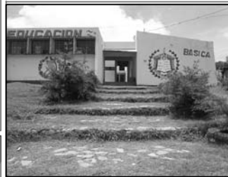
Foto No.1: perspectiva del edificio, techo con bóveda y lamina zinc
