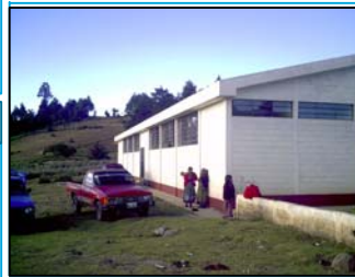
Foto No.2: vista lateral del edificio
