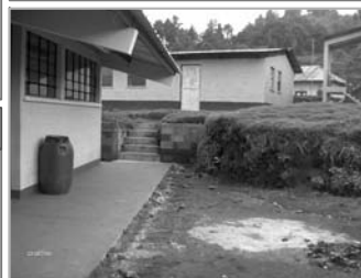
Foto No.2: se puede observar que el edificio en general se encuentra en buen estado
