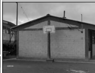
Foto No.1: perspectiva del edificio, techo de dos aguas de lamina zinc.
