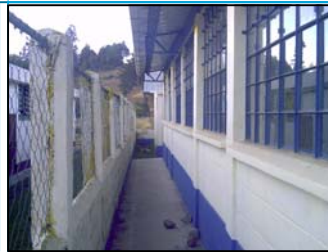
Foto No.3: ventanas en buen estado
