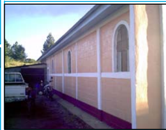
Foto No.2: vista lateral del edificio
