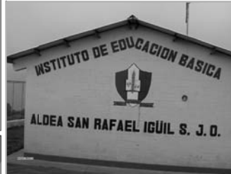
Foto No.1: perspectiva del edificio, techo de dos aguas de lamina zinc.
