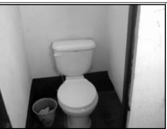
Foto No.3: inodoros en buen estado
