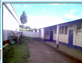
Foto No.3: Vista interior del predio
