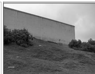
Foto No.7: talud existente en la parte posterior del salon
