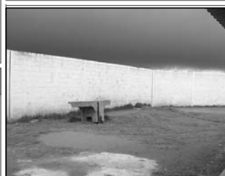
Foto No.2: muro perimetral 2m de altura construido con block.
