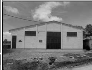
Foto No.1: perspectiva del edificio, techo a dos aguas y lamina zinc
