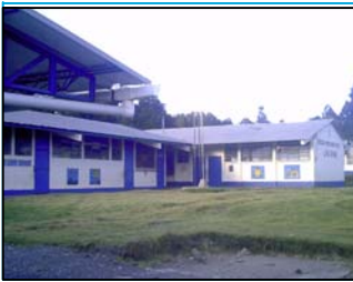
Foto No.3: Vista interior del predio
