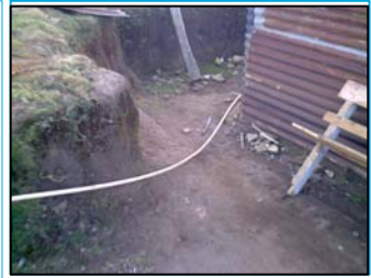
Foto No.7: tubería pvc expuesta
