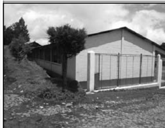
Foto No.1: perspectiva del edificio, techo lamina zinc
