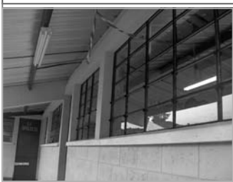
Foto No.1: se puede observar que las condiciones de las ventanas de este edificio se encuentran en buen estado.
