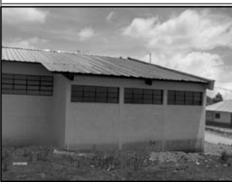
Foto No.1: techo en buen estado
