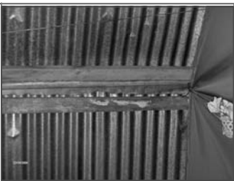
Foto No.2: la estructura del techo y las laminas se encuentran en buen estado
