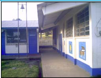
Foto No.2: piso de torta de concreto
