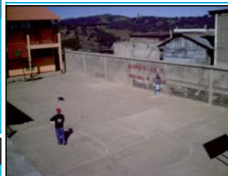
Foto No.3: area de cancha interna del edificio
