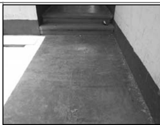
Foto No.2: piso torta de granito
