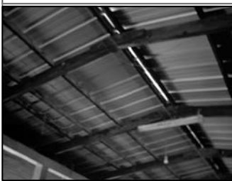
Foto No.1: techo en buen estado
