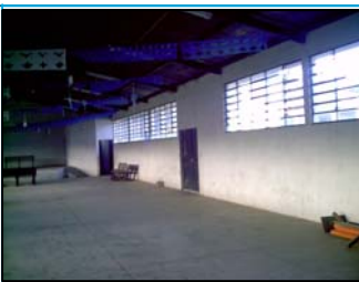
Foto No.2: piso de torta de concreto
