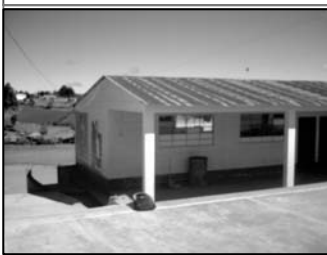
Foto No.1: techo en buen estado
