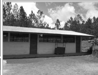
Foto No.1: perspectiva del edificio con sus respectivos ingresos
