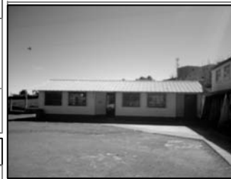
Foto No.3: aulas nuevas construidas por intervida
