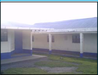
Foto No.1: techo de lamina a dos aguas
