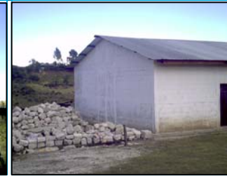
Foto No.4: ripi en la parte posterior del edificio
