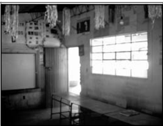
Foto No.2: ventanas en buen estado
