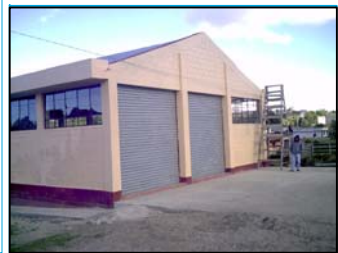
Foto No.4: vista lateral del edificio en buenas condiciones
