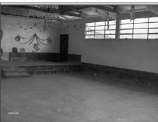
Foto No.2: interior del salon piso de torta de cemento.
