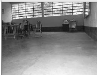
Foto No.2: piso torta de concreto
