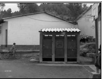
Foto No.3: fotografia area de servicio sanitario.
