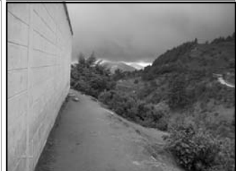
Foto No.7: talud existente en la parte posterior del salon
