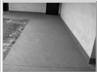
Foto No.5 y 6: piso exterior de torta de concreto en buenas condiciones
