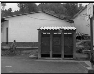
Foto No.3: fotografia area de servicio sanitario.
