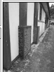
Foto No.2: columnas resaltadas de cubiertas de piedra
