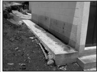
Foto No.7: cimentacion expuesta por corrosion
