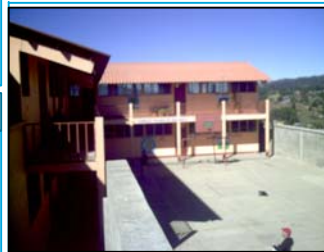
Foto No.2: area interna del edificio
