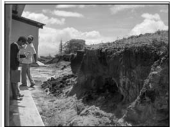
Foto No.5 y 6: talud cercano al edificio 1m de separacion
