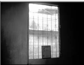
Foto No.2: ventanas en buen estado
