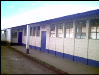
Foto No.2: piso de torta de concreto
