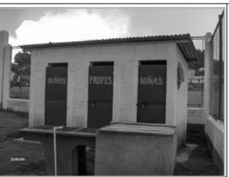
Foto No.3: area de servicio sanitario
