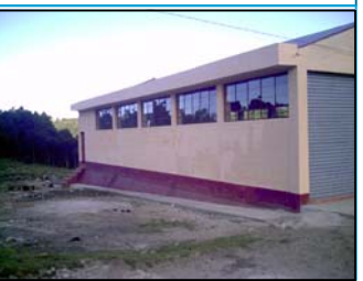
Foto No.4: vista lateral del edificio en buenas condiciones
