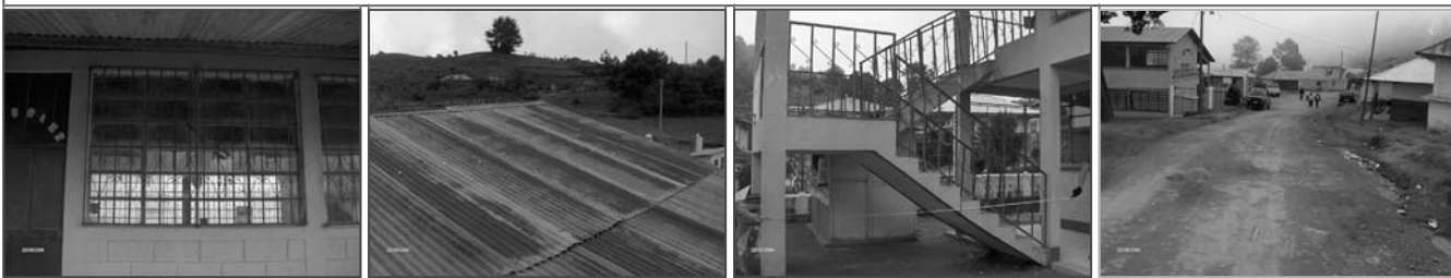
Foto No.1: se puede observar que las condiciones de las ventanas de este edificio se encuentran en buen estado.
