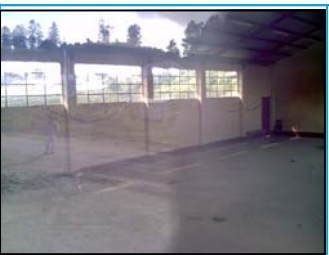
Foto No.3: ventanas en buen estado
