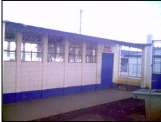
Foto No.3: ventanas en buen estado
