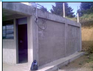
Foto No.3: paredes de block visto puertas de metal
