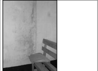
Foto No.7: humedad en paredes interiores
