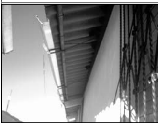
Foto No.1: techo en buen estado
