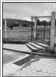
Foto No.2: muro perimetral de block con malla
