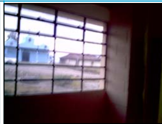
Foto No.3: ventanas en buen estado
