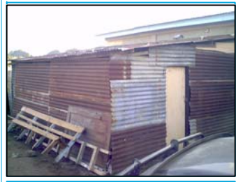
Foto No.5 y 6: galera utilizada como bodega
