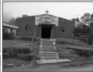
Foto No.1: perspectiva del edificio, techo de dos aguas de lamina zinc.
