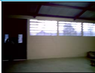
Foto No.2: piso de torta de concreto
