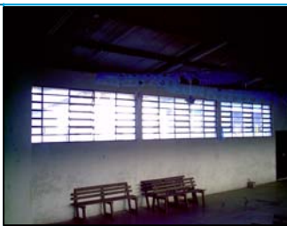
Foto No.3: ventanas en buen estado
