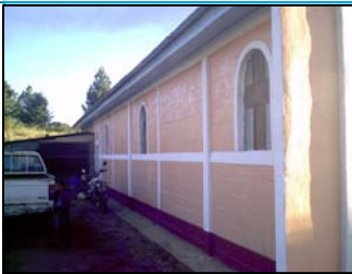
Foto No.3: ventanas en buen estado
