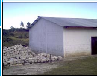
Foto No.2: vista posterior del edificio
