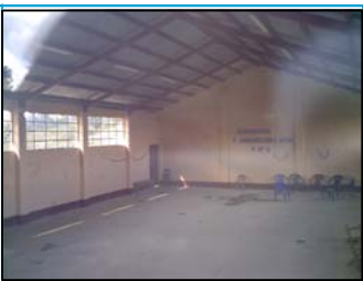
Foto No.2: piso de torta de concreto
