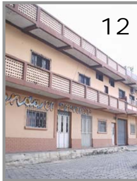
Vivienda de 2 niveles
