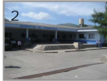
Hospital Nacional de El Progreso
