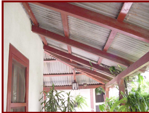
INGRESO A VIVIENDA
