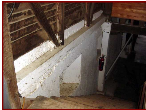
MURO ANTIGUO DE ADOBE ES HOY BASE DE ESTRUCTURA EN BENEFICIO Fotografía propia No 26 , ubicación ingreso a primer nivel de beneficio ref. NO.4 en gráfico No.5
