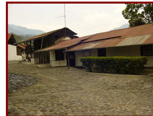
FACHADA MODULO DE OFICINAS ADMINISTRATIVAS Fotografía propia No 28, orientación Norte
