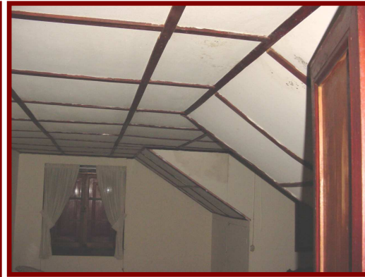
ESTRUCTURA EN CIELO FALSO
