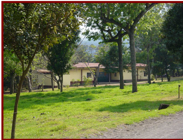
ESCUELA DE LA FINCA Fotografía propia No 50 , ubicación Norte ver el edificio se encuentra fuera del casco de la finca. Ref. A en gráfico NO.1 "B"
