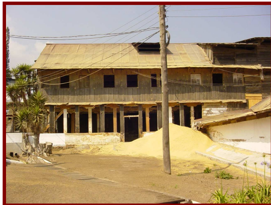
BENEFICIO ANTIGUO FABRICADO CON MADERA DEL LUGAR (Ciprés) Fotografía propia No 23, orientación al Nor Este ref. D en gráfico NO.1 "B"
