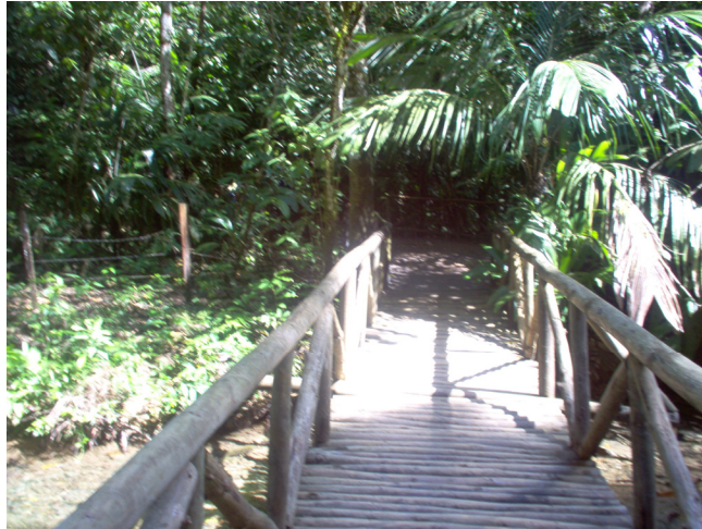
Fotografía: puente de madera. Fuente: Elaboración propia.
