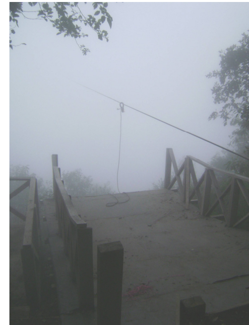
Fotografía: Plataforma para canopy. Fuente: Elaboración propia/Mayo 2008
