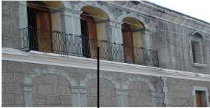
FOTOGRAFÍA No.19: BALCONES DE ACERO FORJADO COLONIALES EN TODA LA PARTE SUPERIOR DE LA MUNICIPALIDAD, SUS VENTANAS SON DE MADERA CON ACABADOS SENCILLOS.
