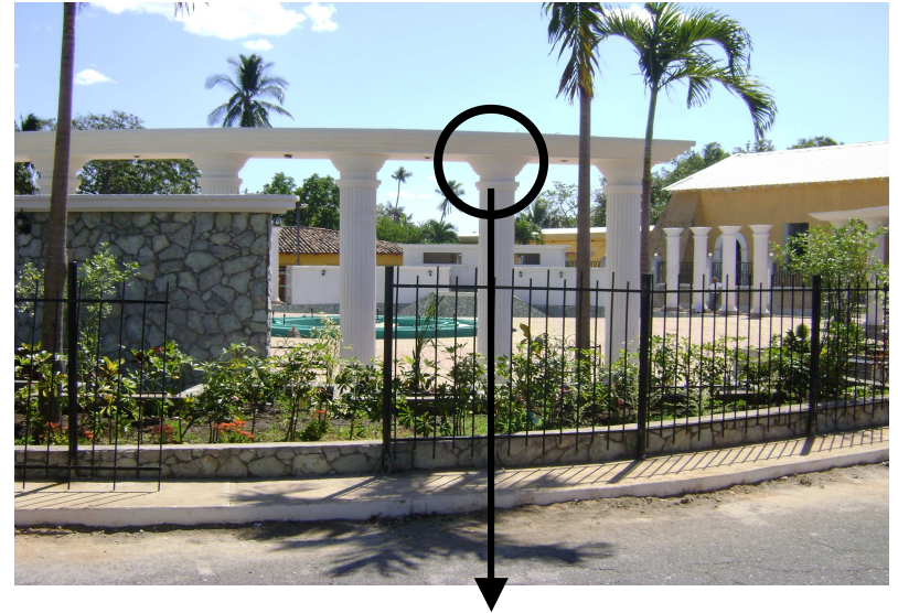
FOTOGRAFÍA No 28: IMAGEN DEL PARQUE, PROYECTO DONDE SE USARON DIFERENTES ELEMENTOS ARQUITECTÓNICOS COMO PODEMOS OBSERVAR EN SUS COLUMNAS Y EN EL MURO DIVISIONAL QUE SE UNE CON LA BANQUETA, EN EL PISO SE USO LADRILLO ECOLÓGICO.
