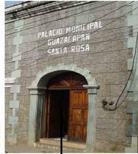
FOTOGRAFÍA No 20 SE OBSERVA QUE LA PUERTA PRINCIPAL DE LA MUNICIPALIDAD ES DE MADERA CON ACABADOS SENCILLOS Y AL CONTORNO UN REMATE DE CONCRETO CON DOS PILARES QUE ESTAN UNIDOS POR UN ARCO .
