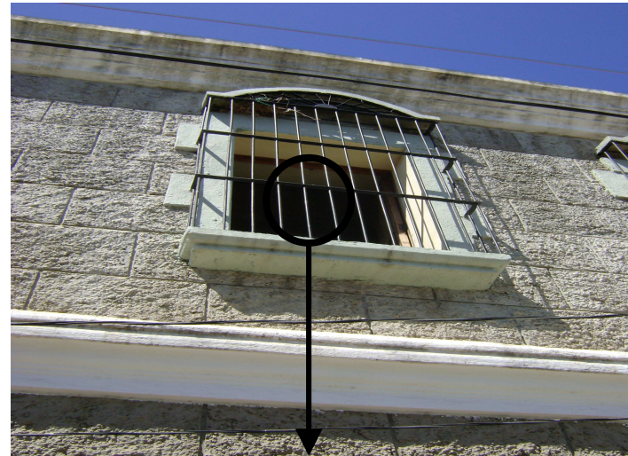
FOTOGRAFÍA No 24: LA VENTANERÍA ES DE MEDIO ARCO DECORADOS CON ACERO FORJADO LISOS, SIN DECORACIÓN, ESTAN ELABORADAS DE MADERA CEDRO, SUS FACHADAS ESTÁN HECHAS DE RUSTIBLOCK.
