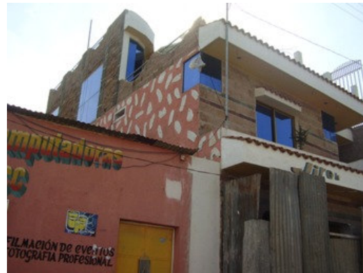
Imagen no.4 Construcciones como ésta, son el resultado de una dinámica urbana no regulada debido a la falta de estudios técnicos que orienten la gestión de áreas patrimoniales. Fotografía propia, mayo 2008.
