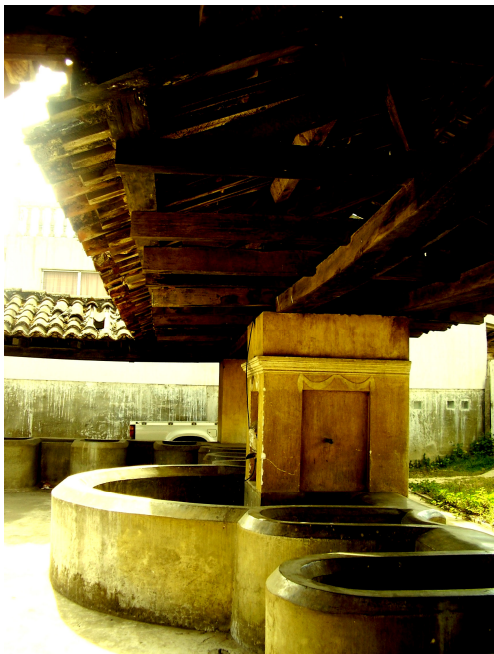
Imagen no. 62 Tanque Público (1878) (Fotografía Propia, marzo 2008)
