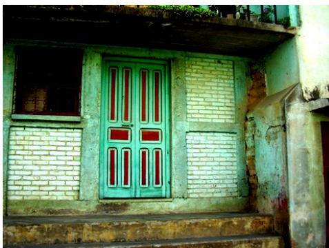
Imagen no. 122 Casa Patrimonial en 2ª calle (Fotografía propia, mayo 2008)
