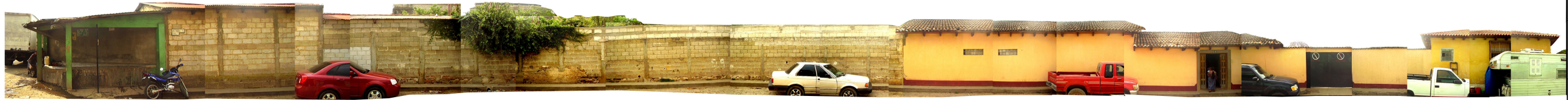
Imagen no. 86 Fachada de la 4ª avenida "A". (Fotografía propia, mayo 2008)
