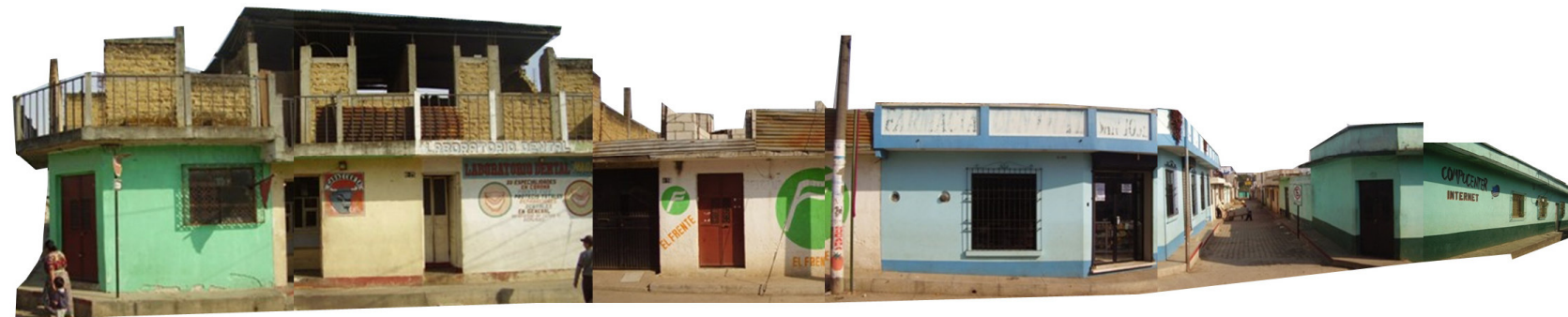
Imagen no. 106 Sección 1 de Fachada de la 6ª avenida. (Fotografías propias, mayo 2008)
