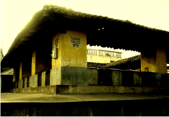
Imagen no. 47 Tanque sobre 3ª calle. (Fotografía Propia, marzo 2008)
