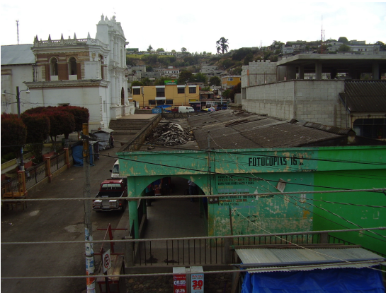
Imagen no. 1 Deterioro del entorno patrimonial dado por construcciones que no se integraron a la imagen urbana del lugar. Al fondo templo de San Bernardino, inmueble patrimonial registrado, categoría A. Fotografía propia, mayo 2008.
