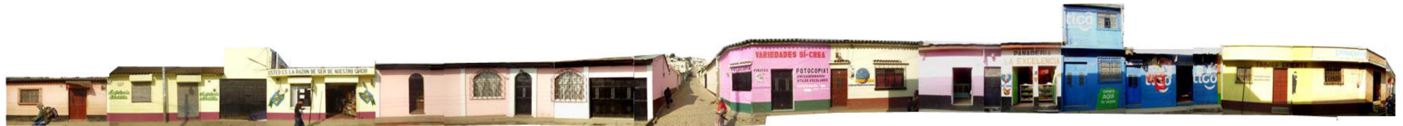
Imagen no. 132 Fachada del Estado Actual de la 5ª calle (Fotografías propias, mayo 2008)
