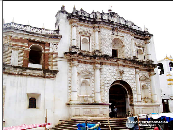
Imagen no. 11 Iglesia de San Bernardino (Fotografía proporcionada por Servicio de Información Municipal.)
