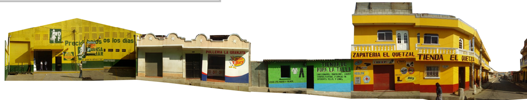
Imagen no. 107 Sección 2 de Fachada de la 6ª avenida. (Fotografías propias, mayo 2008)
