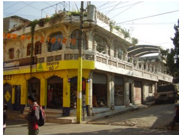
Imagen no. 119 Inmueble en esquina de la 6ª avenida y 3ª calle. (Fotografía propia, mayo 2008)
