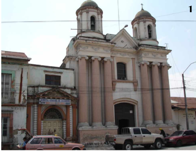
Deterioros Físicos: Presencia de humedad en los campanarios de la Iglesia. Presencia de Oxido en la cubierta del antiguo Hospital de San Juan de Dios.
