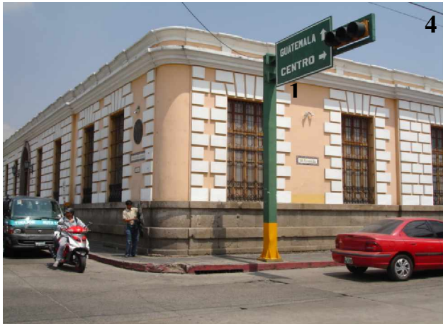
Deterioros Conceptual: Colocación del Semáforo. Agrietamiento en pavimento de las avenidas.
