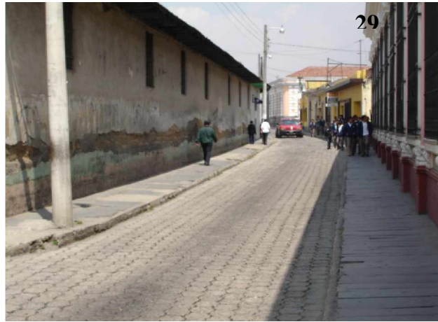
Deterioros Físicos: Faltantes en acabados en pared del antiguo Hospital San Juan de Dios y presencia de humedad. Falta de unidad constructiva en la acera del Hospital. Deterioro Conceptual: Poste de alumbrado público.
