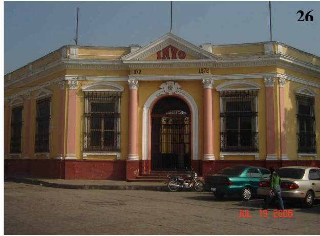
Deterioros Físicos: Por el uso de materiales ajenos al lugar, como la utilización de adoquín.
