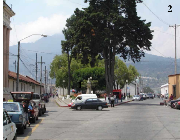
Deterioro Conceptual: Contaminación visual por postes de energía eléctrica. Agrietamiento en pavimento de las avenidas.
