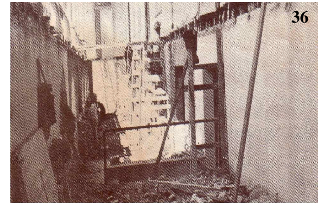
Se puede apreciar que los pisos de machihembre de los corredores del 2do. Patio fueron sustituidos por concreto, en el año Centenario bajo la dirección del Ingeniero Carlos Solórzano
