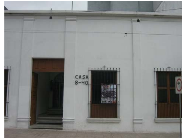
Foto 5 Categoría "D" ubicado en la 5ª avenida casa 8-40 dentro del Núcleo Central, del Centro Histórico Fuente: Propia octubre2008
