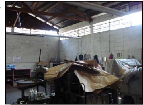
Foto 10: Se tapan máquinas para evitar daños por efecto de insectos en el techo.
