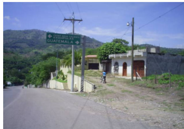
Foto 42. Vivienda unifamiliar en el ingreso al municipio de Jocotán, utilización de block pómez u losa de concreto armado. Fuente: fotografía propia.
