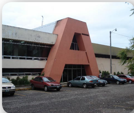
Fotografía: Silvia Palma Fachada Facultad de Arquitectura
