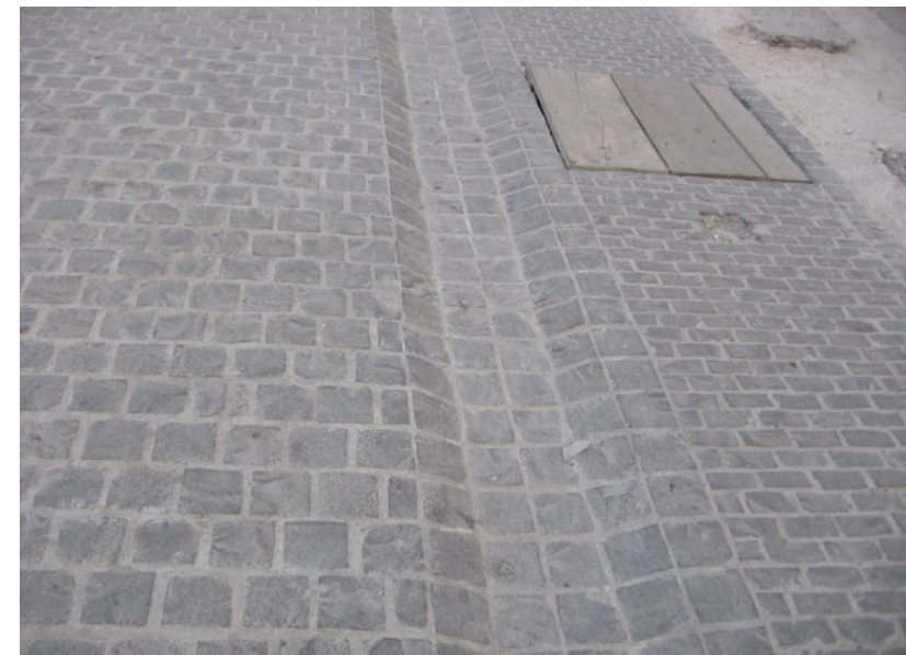
Ilustración 116. Piedra Canteada para canales pluviales de 0.10 * 0.10 mts. Fuente: Urbanística, Materiales de Construcción en uso en el Centro Histórico 2009. Foto tomada por Walter Esquivel enero del 2009.
