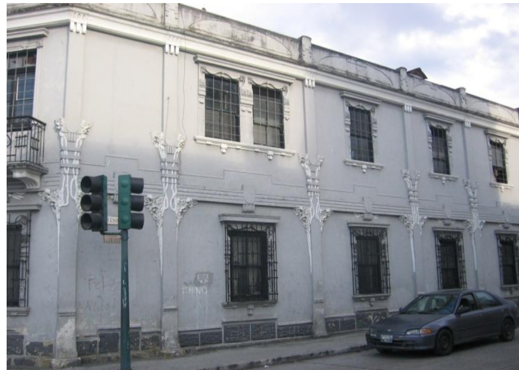
Ilustración 46: Inmueble ubicado en el 15-17, esquina con estilo Ecléctico. Fuente: Foto tomada por Walter Esquivel.
