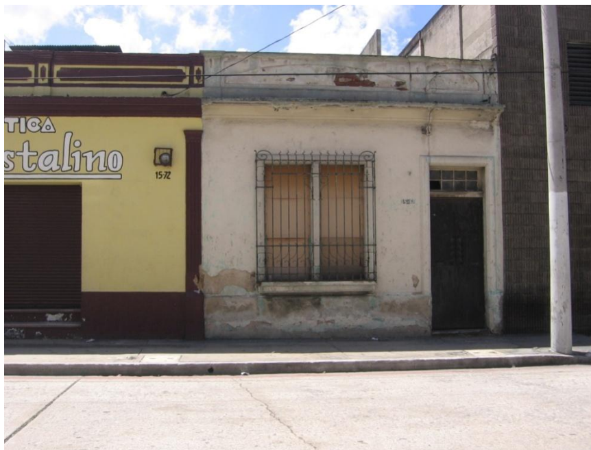
Ilustración 56: Vivienda Estilo Neoclásico Fuente: Foto tomada por Walter Esquivel 2008.
