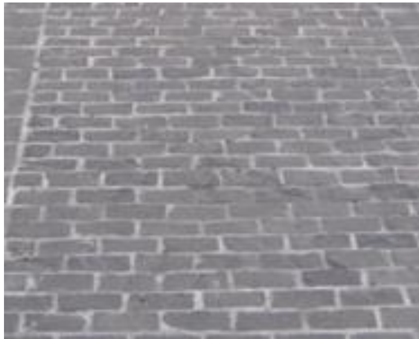
Ilustración 115. Piedra Canteada de 0.10 * 0.05 mts. * 0.06 mts. Fuente: Urbanística, Materiales de Construcción en uso en el Centro Histórico 2009. Foto tomada por Walter Esquivel enero del 2009.
