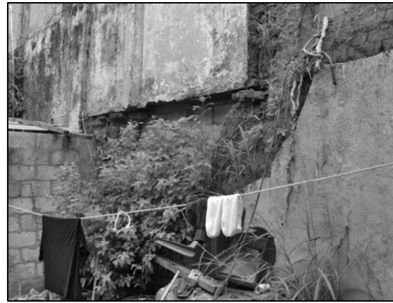
FOTO No.55. Muro colindante contiguo a bomba
