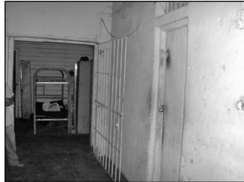
FOTO No.28. Ingreso lateral hacia comedores
