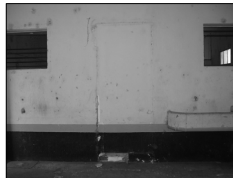
Estado General de Muros Internos
