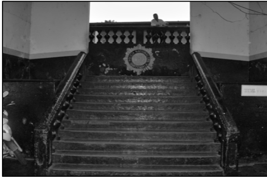
FOTO No.27. Escalera de Ingreso Principal
