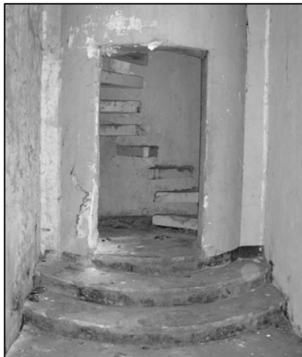
FOTO No.62. Gradas torrecilla Norte para subir a techo
