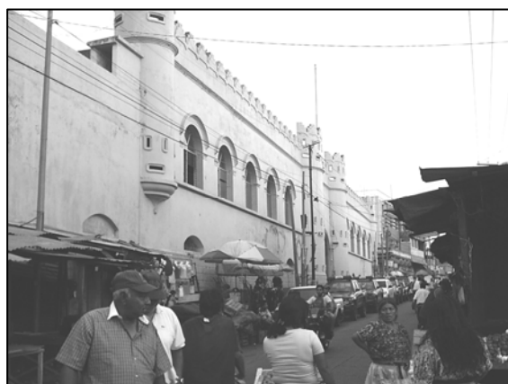
FOTO No.15 4ª Av. Ventas frente a edificio en estudio.
