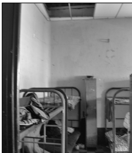
FOTO No.68. Cielo falso dormitorio oficiales
