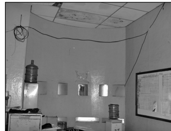
FOTO No.72. Instalaciones oficina DINC 1er nivel
