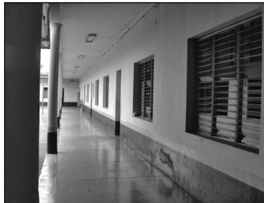
FOTO No.65. Corredor externo hacia patio lado este
