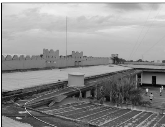
FOTO No.78. Instalaciones de agua potable
