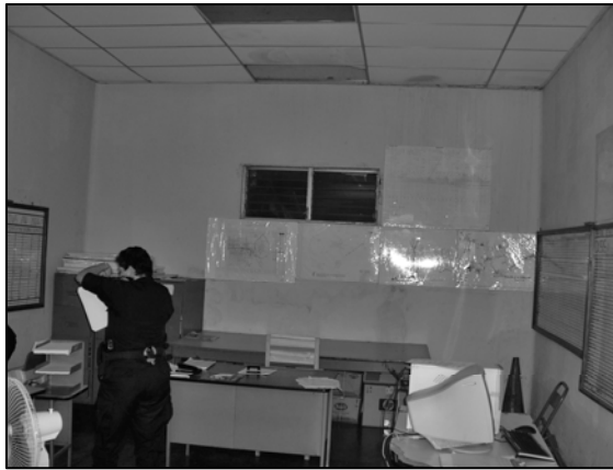
FOTO No.59. Oficina sección de personal 1er nivel
