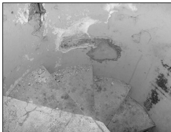
FOTO No.69. Gradas torrecilla hacia sótano
