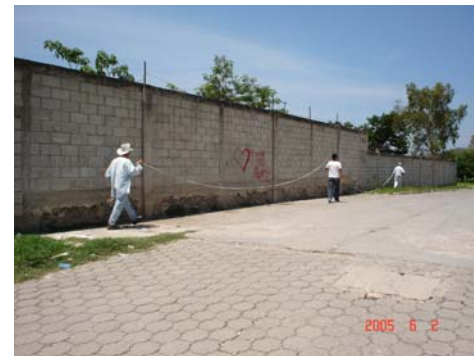
Foto 4 Vista Nor-Oeste. El muro perimetral, tiene de alto 3 m. su estado es irregular. Pero no cumple con Las especificaciones de seguridad y función.
