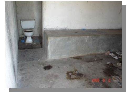
Foto 11 Este es el estado actual de los vestidores y S.S. Los artefactos sanitarios ya no funcionan. Por esto mismo el área que servía de vestidores, hoy se ha convertido en un lugar para hacer necesidades fisiológicas. Creando problemas higiénicos.
