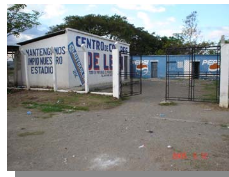
Foto 10 Vista Nor-Oeste interna del “estadio”. Estos son los vestidores y baños públicos. No tienen vida útil: esto, por falta de higiene, y porque ya no se dan abasto
