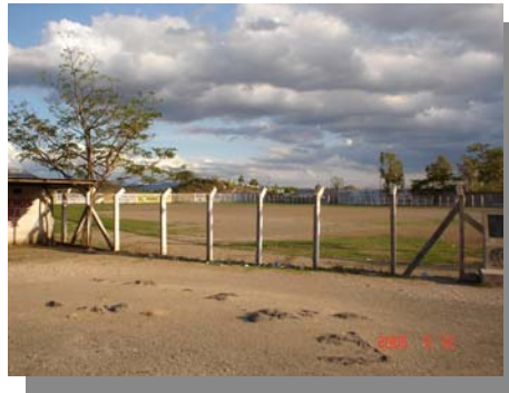
Foto 7 Vista interior de las instalaciones; como se puede apreciar la “cancha” está en total abandono.
