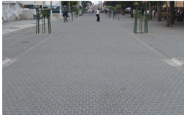
Imagen 153: Banda de rodadura piedra de Basalto 20 x 20 cms. Fuente: Manuel Soto. Febrero 2009
