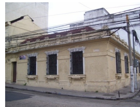
Imagen 45: Casa ubicada en la esquina de 11 calle y 6ª avenida "A" 6-34, zona 1. Autor: A. Jurado. Diciembre 2008.
