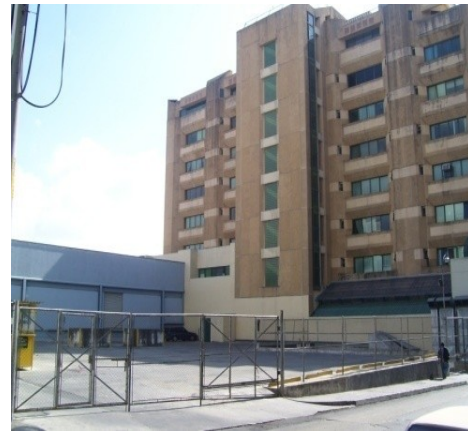
Imagen 163: Parqueo publico a lado del Edificio de Banco Promotor 10ª calle zona 1.
