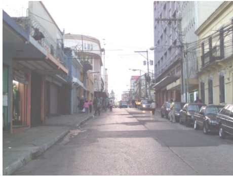
Imagen 52: Área del Vehículo en la 11 calle. Se observa que el ancho de la carpeta de rodadura permite la circulación de dos vehículos y de un área de parqueo al lado derecho, también se observa que casi en su totalidad el concreto se encuentra en regular estado. Autor: A. Jurado. Diciembre 2008.
