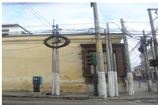
Imagen 107: Señalización; Semáforos. Los semáforos que se encuentran en este sector son tipo flecha, los cuales funcionan perfectamente. Autor: A. Jurado. Diciembre 2008.
