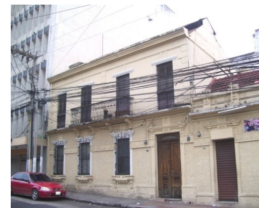
Imagen 138: Usos del Suelo; Bodega. Este local ubicado en la 11 calle es una casa utilizada para bodega de productos varios.
