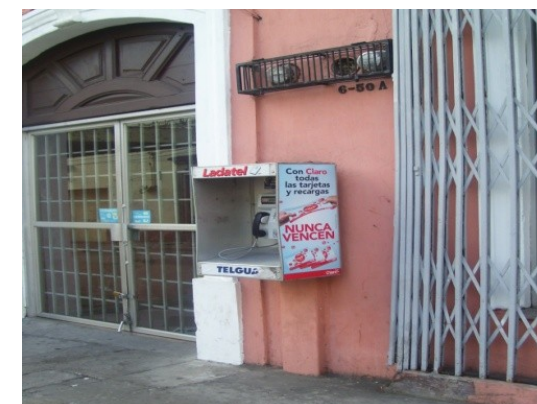
Imagen 81: Infraestructura; Telefonía Pública. Aquí encontramos una cabina telefónica tipo tarjetera, esta ubicada en la 11 calle, frente al local de librería Piedra Santa y es causa de interrupción de paso peatonal. Autor: A. Jurado. Diciembre 2008.
