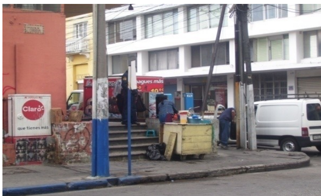
Imagen 76: Infraestructura; Iluminación Pública. Este es uno de los postes del tendido eléctrico que se encuentran del lado contrario de la calle, no posee luminaria. Autor: A. Jurado. Diciembre 2008.
