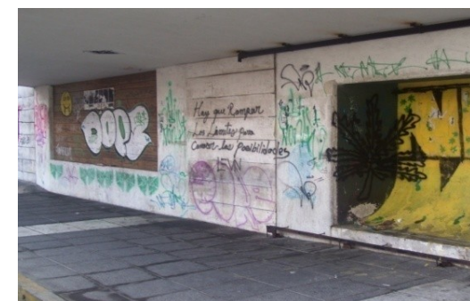
Imagen 119: Grupos Vulnerables; Delincuencia y Maras. Son pocos los lugares en los que se encuentran las pintas de maras existentes, estas las realizan principalmente en los muros donde se ubica el antiguo Hotel Ritz. Autor: A. Jurado. Diciembre 2008
