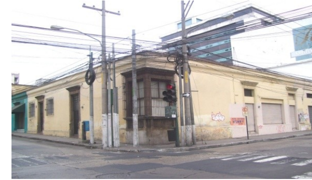
Imagen 74: Infraestructura; Iluminación Pública. Los postes del tendido eléctrico se encuentran en un solo lado de la calle y callejón, todos son de concreto en buen estado. Autor: A. Jurado. Diciembre 2008.
