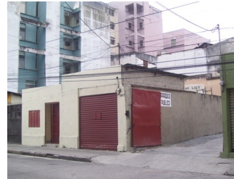
Imagen 55: Inmueble con uso para Parqueo Público en Callejón Tasso. Existen tres Parques; dos públicos con capacidad para unos 80 vehículos y uno privado (Hotel Ritz) Autor: A. Jurado. Diciembre 2008.
