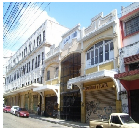
Imagen 165: Fachada Pasaje Rubio En la 9ª calle zona 1
