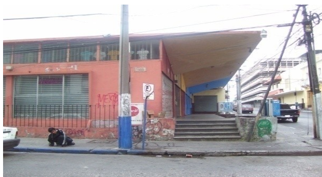
Imagen 91: Contaminación Ambiental; Desechos Sólidos. Las esquinas del callejón Tasso y otras áreas del sector de estudio se han convertido en puntos de contaminación debido a la presencia de indigentes que no tienen sanitarios y hacen uso de las banquetas para sus necesidades fisiológicas.
