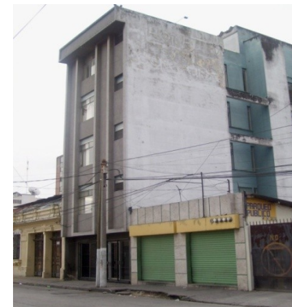
Imagen 48: Edificio en Callejón Tasso 6ª avenida “A”, 10-52, zona 1.
