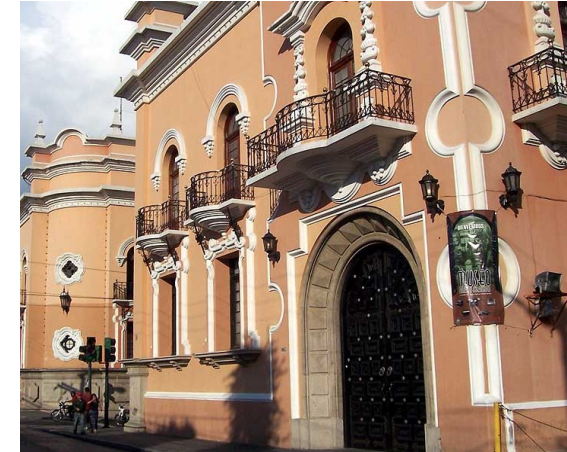
Imagen 22: Arquitectura Neocolonial; Antiguo Edificio de Correos Fuente: www.skyscraperlife.com
