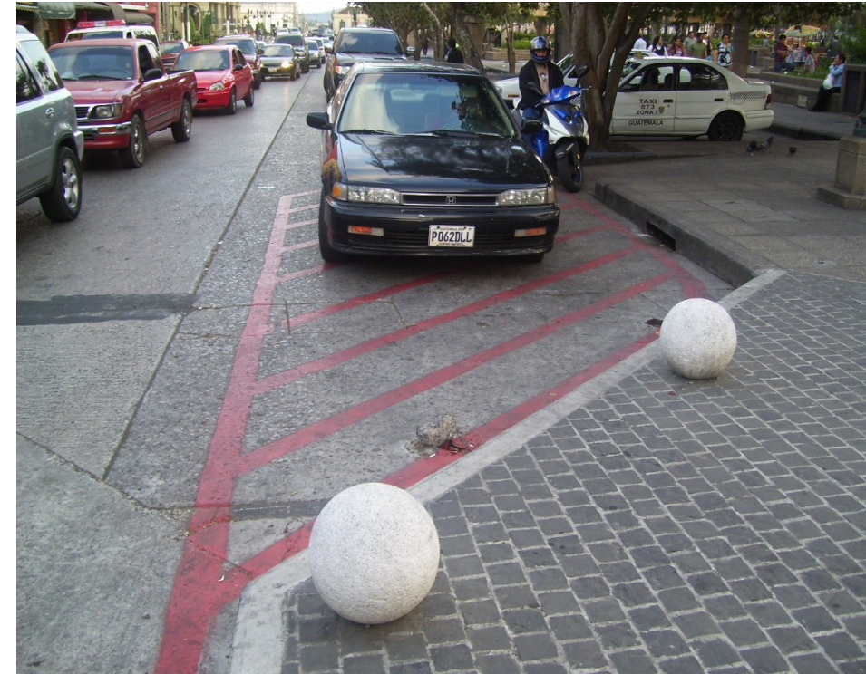
Fotografía: BOLARDOS ESFÉRICOS PARA USO DE PARQUEO Autor: A. Jurado. Diciembre 2008. Plaza Central, Centro Histórico
