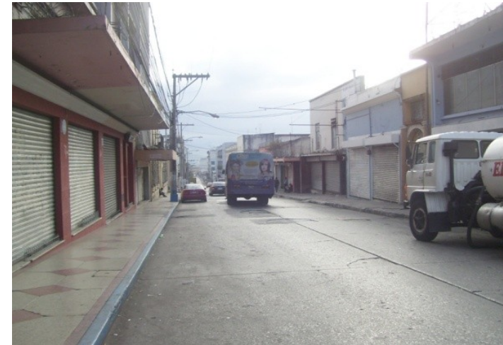
Imagen 154: Banda de rodadura de concreto reforzado en tramo de 11 calle. Fuente: A. Jurado. Diciembre 2008
