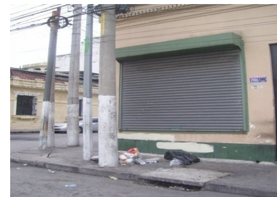
Imagen 80: Infraestructura; Televisión por Cable. Los postes del servicio del cable se localizan junto a los postes de energía eléctrica. Autor: A. Jurado. Diciembre 2008.
