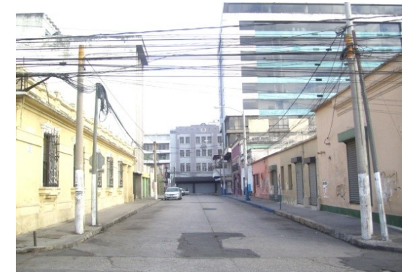
Imagen 75: Infraestructura; Iluminación Pública. Se observan varios de los postes de concreto. Autor: A. Jurado. Diciembre 2008.
