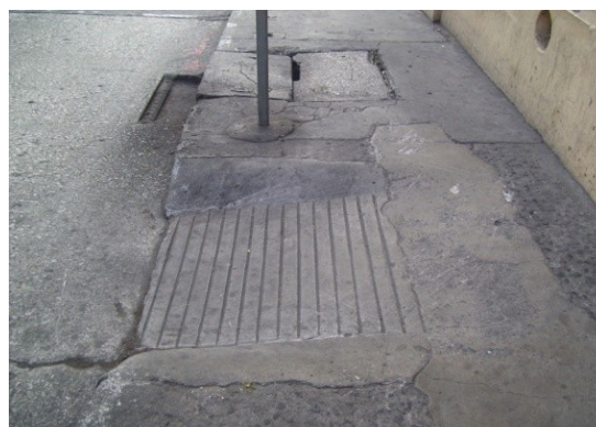
Imagen 61: Estado actual de banquetas. Se observa que existen rampas para minusválidos en de las esquinas de las intersecciones, sin embargo el estado de la banqueta es deplorable. Autor: A. Jurado. Diciembre 2008.
