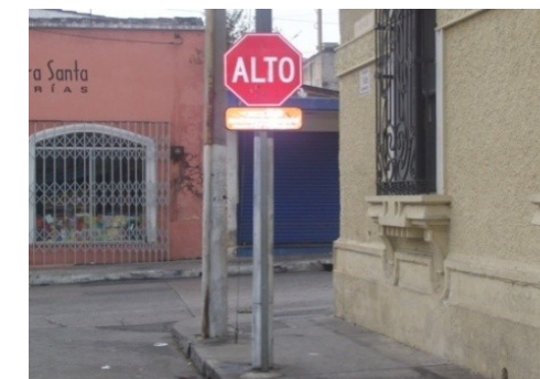
Imagen 108: Señalización; Altos. Los encontramos en las las esquinas, su material es de lámina galvanizada, pintura reflectiva y poste de aluminio. Autor: A. Jurado. Diciembre 2008.
