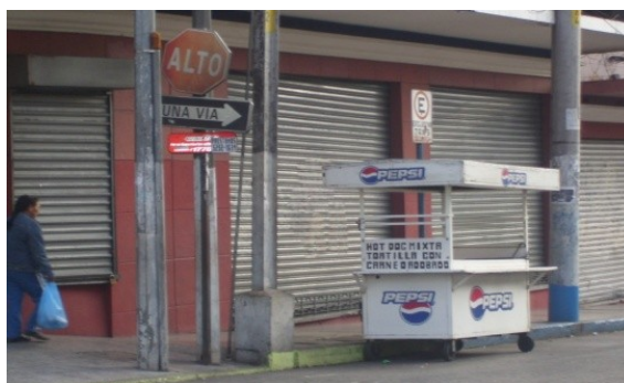
Imagen 110: Señalización; Vías. Se les encuentra en las esquinas, indicando el sentido de las calles tienen el mismo material de los altos y en su mayoría se encuentran en regular estado. Autor: A. Jurado, Diciembre 2008.
