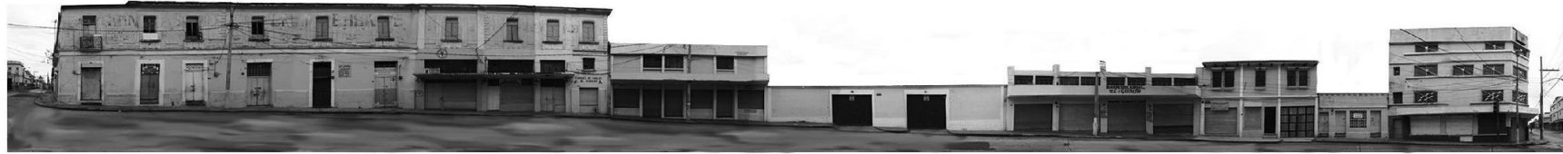
7ma. Calle Oriente, de 9na. a 10ma. Avenida, FACHADA NORTE
