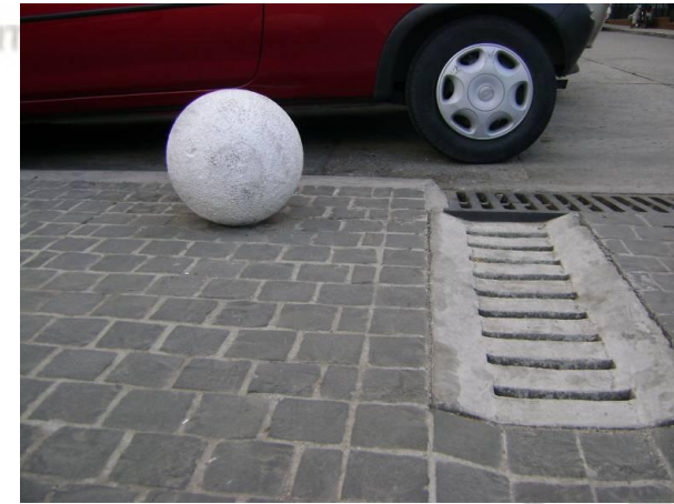
Ilustración 2, Detalle de la rigola o canal pluvial ranurado, toma personal C.H.
