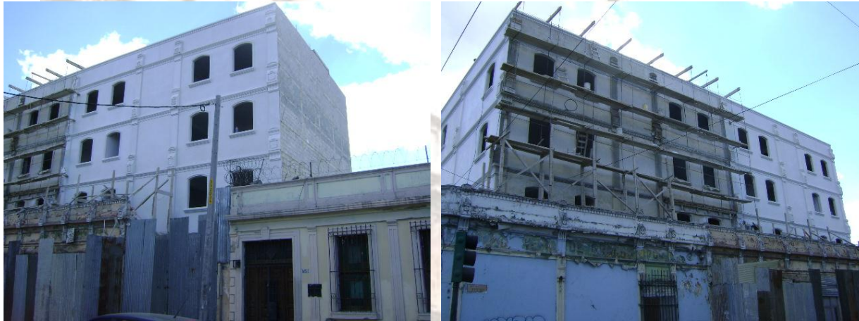
Fotografía 1, Edificio de apartamentos en construcción sobre la 7ª. Calle y 12 Avenida. Frente al antiguo Cine Capri
