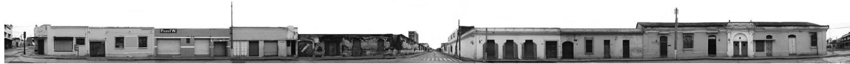
7ma. Calle Oriente, de 10ma. a 11va. Avenida, FACHADA NORTE
