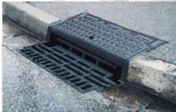
Ilustración 1, Detalle del tragante típico de la Municipalidad de Guatemala, toma personal en el C.H., 2008.
