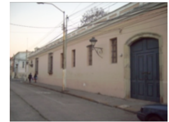
Fotografía 11: Usos del suelo. Edificación categoría "B" uso mixto vivienda / Farmacias del hogar. Buen estado físico.
