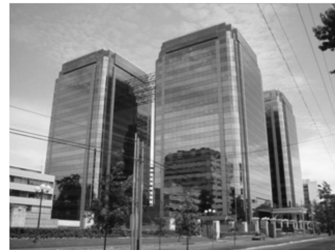
Edificio Euro plaza, zona 14. Ciudad de Guatemala. Fuente: Manuel Soto, 2005.
