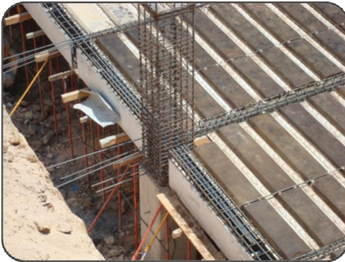
**23.5. Losa:** La losa es un tipo estructural que trabaja a flexión, pero no en sentido lineal como las vigas, son en sentido superficial, lo que se denomina comportamiento de placa, La losa o placa tiene un espesor considerable si la comparan con una lámina estructural predominante en este elemento son el largo y el ancho.
