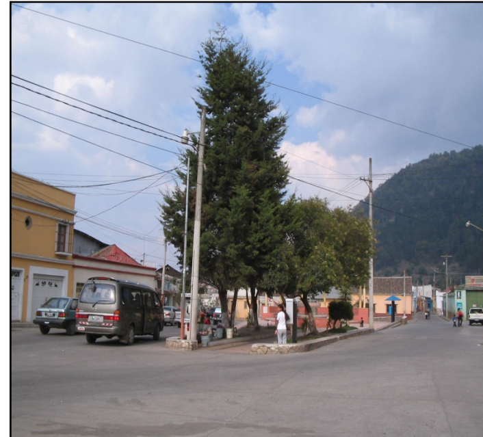
No.42 La fotografía muestra la colocación de algunos de los postes que se encuentran en la plaza y el cableado aéreo y como afectan la imagen urbana. Fuente: Autor.
