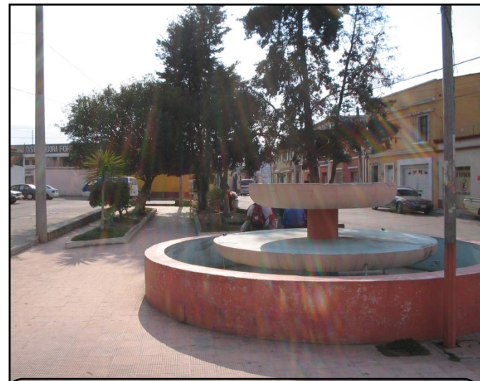
No.37. La fotografía muestra el estado actual de la fuente y el deterioro en que se encuentra. Fuente: Autor
