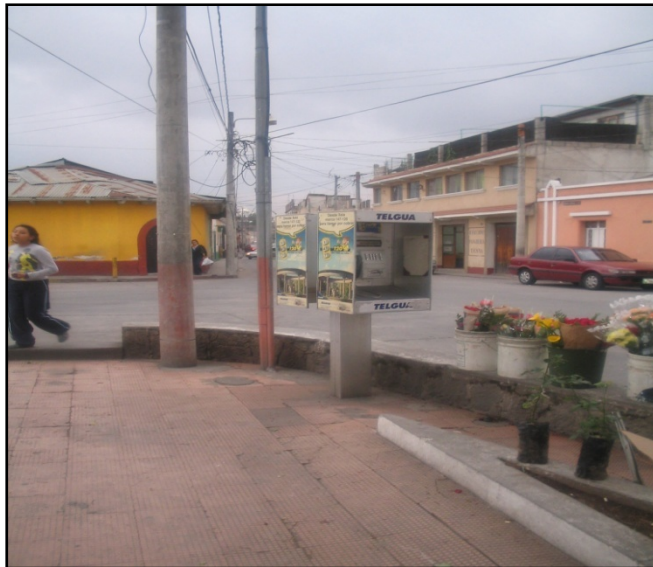
No.40 La fotografía muestra el estado actual del área de piso y el deterioro que presenta. Fuente: Autor
