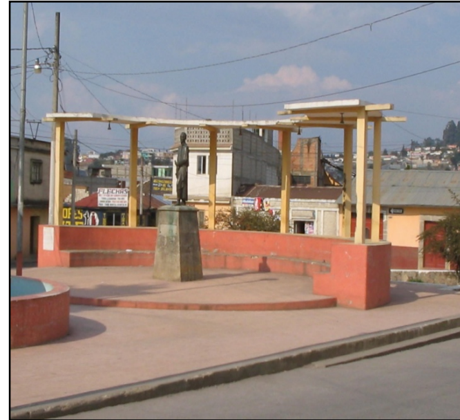
No.39 Se puede observar en la fotografía el mal estado en el que se encuentra esta área y los deterioros que presenta. Fuente: Autor.
