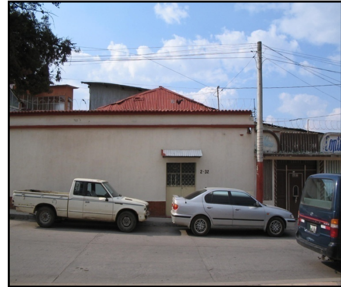
No.24 La fotografía muestra contaminación visual por postes y cableado aéreo y por estacionamiento de vehículos.
