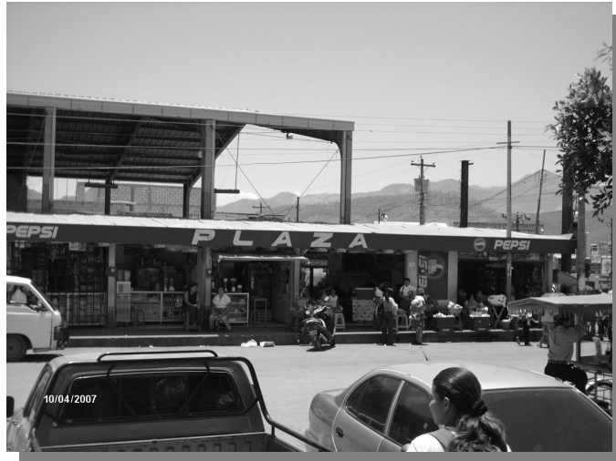
Foto-9 Locales Comerciales.
