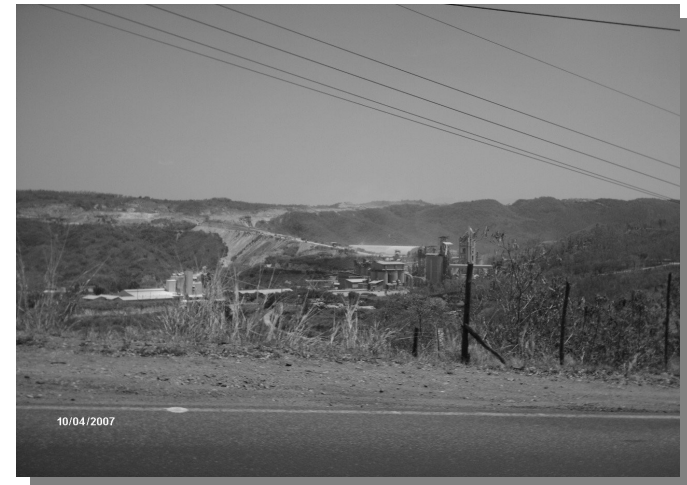
Foto-3 Planta de Cementos Progreso “San Miguel Río Abajo”
