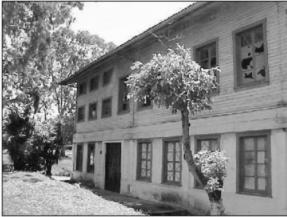
Foto No. 17 Fachada Oeste vista desde el Sur
