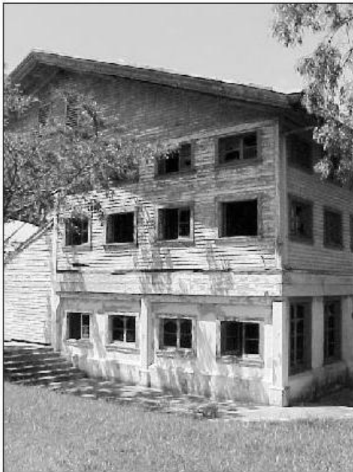
Foto No. 15 Fachada Sur
