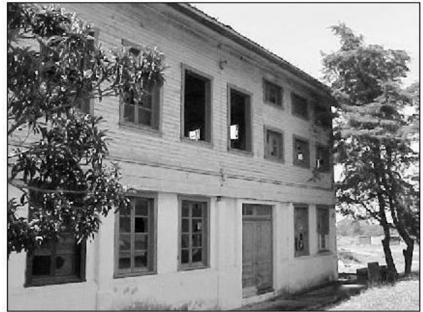
Foto No.18 Fachada Oeste vista desde el Norte
