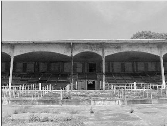
Foto No. 11 Fachada Este
