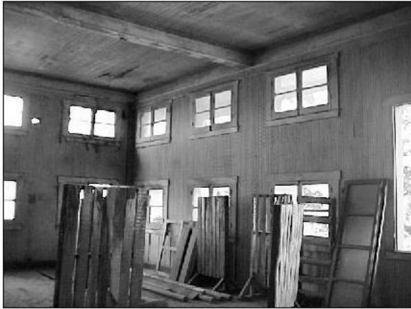
Foto No. 29 Vista Interior Planta Alta Sur
