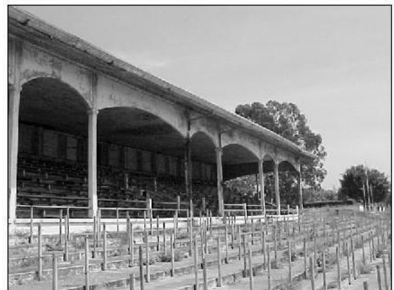
Foto No.10 Fachada Este
