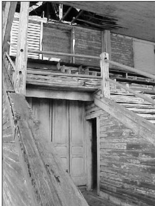
Foto No. 27 Fachada Oeste Ingreso Lateral
