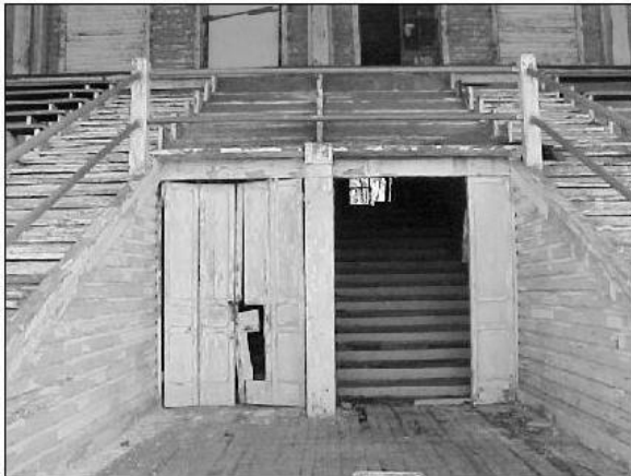
Foto No. 25 Fachada Oeste al Salón Planta Alta
