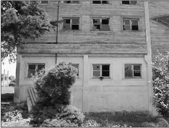
Foto No. 23 Fachada Norte
