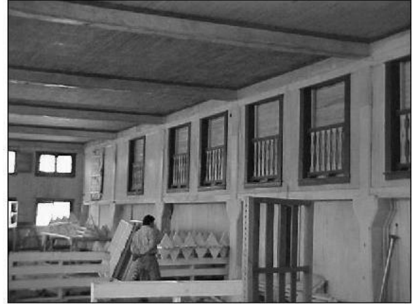
Foto No.30 Vista Interior Planta Alta Norte
