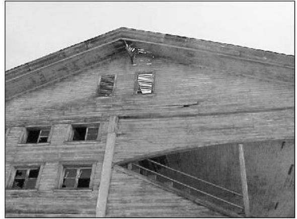
Foto No.24 Fachada Norte
