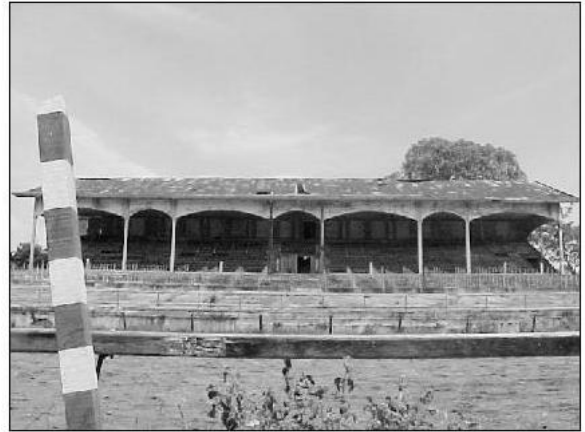
Foto No.12 Fachada Oeste
