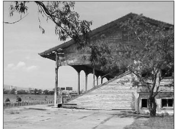
Foto No.14 Fachada Sur
