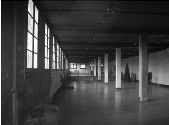
Foto No.34 Vista Interior Planta Baja
