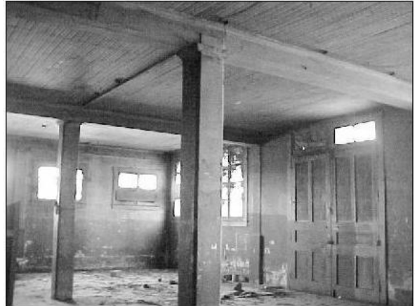
Foto No.32 Vista Interior Planta Baja Norte
