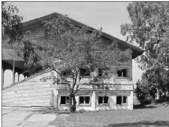
Foto No. 13 Fachada Sur
