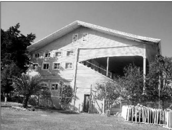
Foto No. 21 Fachada Norte
