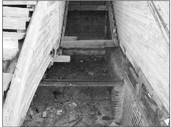
Foto No.26 Fachada Oeste Ingreso Lateral
