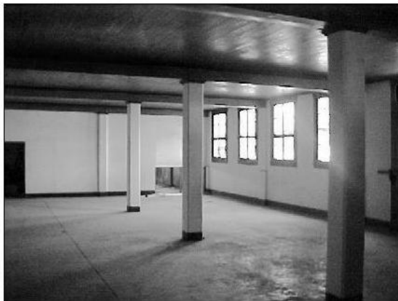
Foto No. 31 Vista Interior Planta Baja Sur
