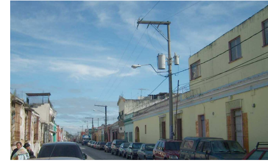
Fotografía 11: Infraestructura; Iluminación Pública. Los postes del tendido eléctrico se encuentran en un solo lado de la calle, la mayoría son de concreto y una menor cantidad de metal. Autor: Manuel Soto, Octubre 2008.
