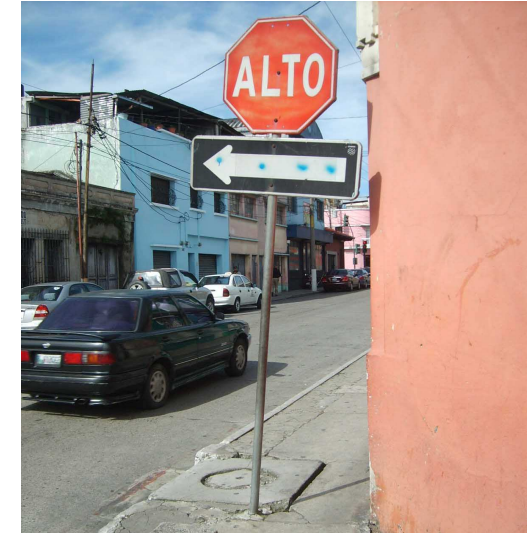
Fotografía 5: Señalización; Altos. Algunos se encuentran doblados por golpes recibidos y también se encuentra una mezcla de señalización. Autor: Manuel Soto, Octubre 2008.
