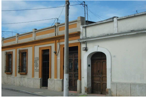
Fotografía 13: Infraestructura; Iluminación Pública. Este es uno de los postes del tendido eléctrico que se encuentran del lado contrario de la calle, no pose luminaria. Autor: Manuel Soto, Octubre 2008.
