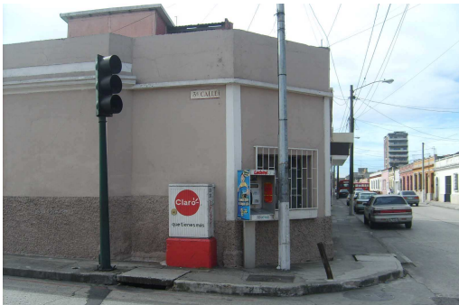
Fotografía 2: Estado actual de banquetas. La ubicación de objetos en las esquinas reduce considerablemente la libre circulación del peatón sobre las banquetas. Autor: Manuel Soto, Octubre 2008.
