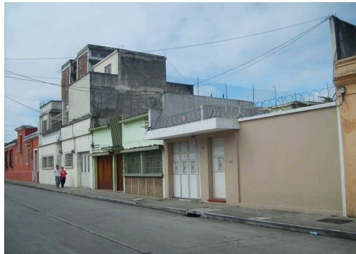
Fotografía 1: Usos del Suelo; Vivienda. En su mayoría las residencias se encuentran en buen estado. Autor: Manuel Soto, Octubre 2008.
