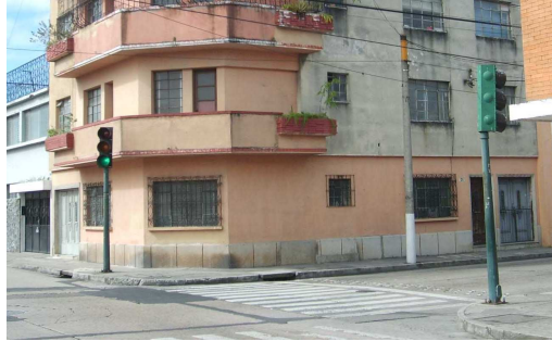
Fotografía 1: Señalización; Semáforos. Actualmente solo existe semaforización en la 3ª calle y 10ª avenida "A". Autor: Manuel Soto, Octubre 2008.
