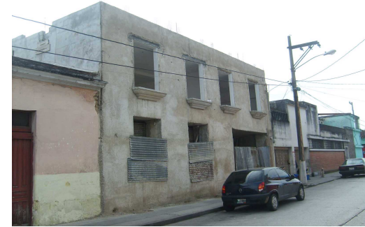
Fotografía 11: Usos del Suelo; Sin Usos. Actualmente existe este inmueble con obras de construcción paralizadas entre la 4ª y 5ª calles. Autor: Manuel Soto, Octubre 2008.
