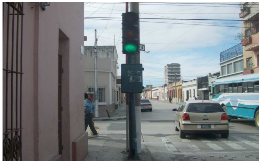
Fotografía 2: Señalización; Semáforos. Los semáforos que se encuentran en este sector son tipo flecha, los cuales funcionan perfectamente, aunque uno de ellos se encuentra un poco torcido. Autor: Manuel Soto, Octubre 2008.
