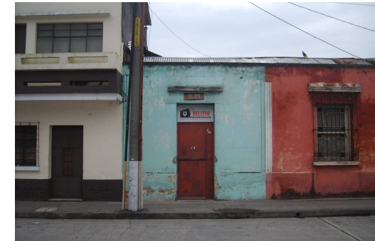
Fotografía 6: Usos del Suelo; Uso Mixto. En algunos casos el uso mixto del suelo fracciona los inmuebles, provocando que existan divisiones interiores, para el desarrollo comercial. Autor: Manuel Soto, Octubre 2008.
