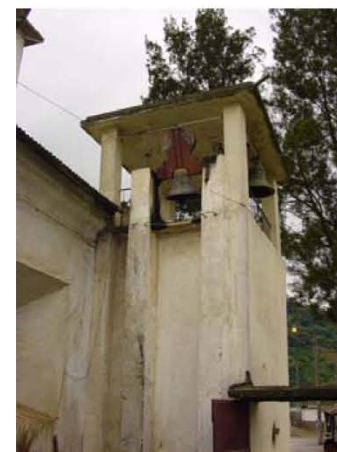
VISTA POSTERIOR DEL MÓDULO DE GRADAS QUE COMUNICA AL CAMPANARIO DE LA IGLESIA. NÓTESE LA DIFERENCIA DE MATERIALES EN LA PARTE SUPERIOR DEL MISMO.
