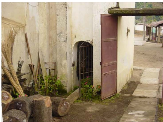
VISTA DEL INGRESO HACIA EL MÓDULO DE GRADAS QUE COMUNICA AL CAMPANARIO, NÓTESE LA ESCALA POR EL TAMAÑO DE LA PUERTA DE INGRESO.
