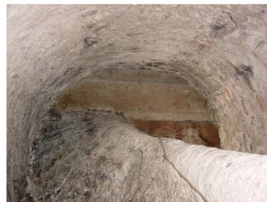
VISTA INTERIOR DEL MÓDULO DE GRADAS, SE OBSERVA EL USO DE TAPIAL.
