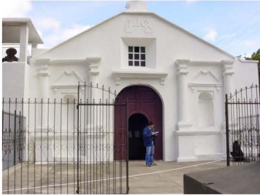
EN LA SEGUNDA VISITA REALIZADA EL EDIFICIO FUE INTERVENIDO CON CAMBIO DE COLOR.
