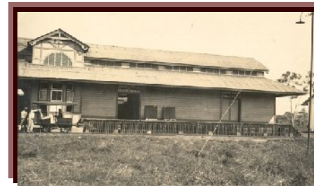
Foto 3-8 Estación Ayutla, 1924. Fuente: Municipalidad de Ayutla, San Marcos.
