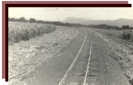
Foto 3-12 Balastro y línea férrea del un tramo en Palín. Fuente: Carlos Torres.
