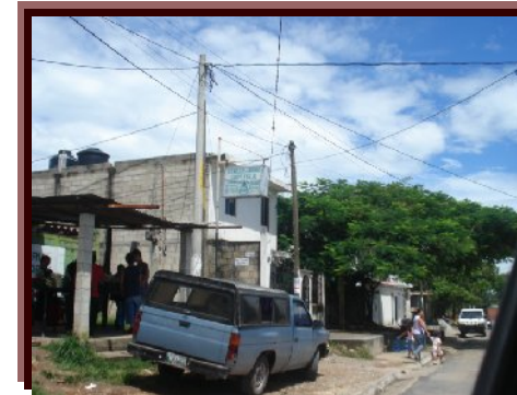
Foto 7-6. Postes de energía eléctrica. Fuente: Visita de campo.
