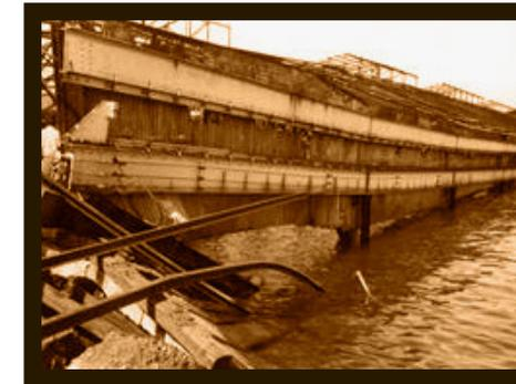
Foto III.13 Daños a la estructura del Puente Agua Caliente, Carretera al Atlántico, por sismo de 1976, visto desde el Puente Agua Caliente del Ferrocarril. Fuente: Archivo FEGUA
