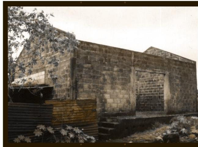
Fotografía No. VI.12 Mal estado de la Bodega rodeada por asentamientos, maleza, y desechos tanto sólidos como líquidos generados por los mismos pobladores del sector que deterioran aún más la estructura.
