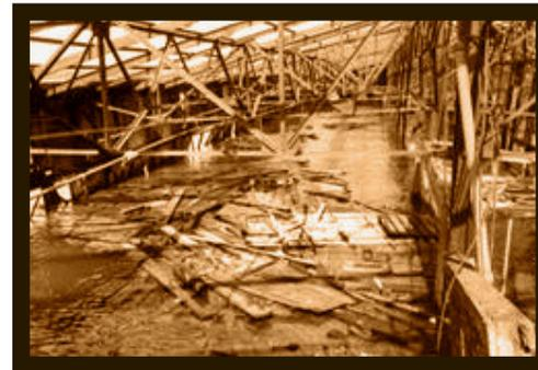
Foto III.12 Daños a la estructura exterior del Muelle Puerto Barrios por sismo de 1976. Fuente: Archivo FEGUA
