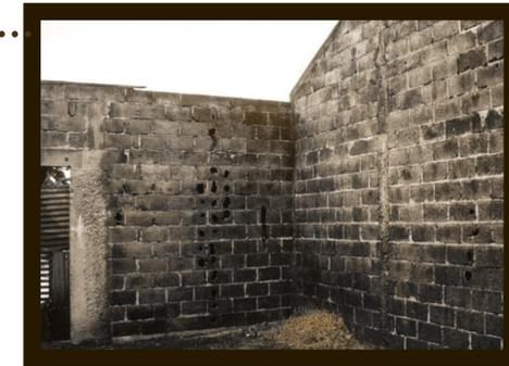
Fotografía No. VI.13 Esta imagen muestra parte del interior de la estructura de la Bodega con muros de block visto y en completo deterioro.
